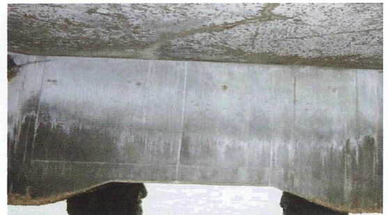
写真-3 10年経過後の梁の状況
