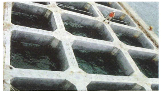
写真-2 補修終了後の梁
