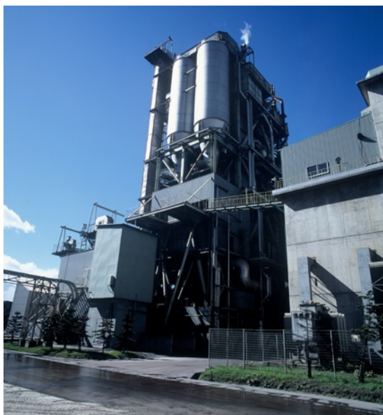
写真10 石炭焚自家発電設備
