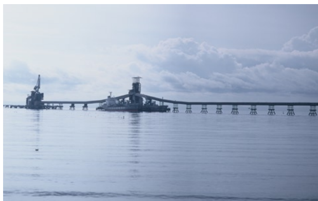
写真2 2kmにわたって延びる海上栈橋
