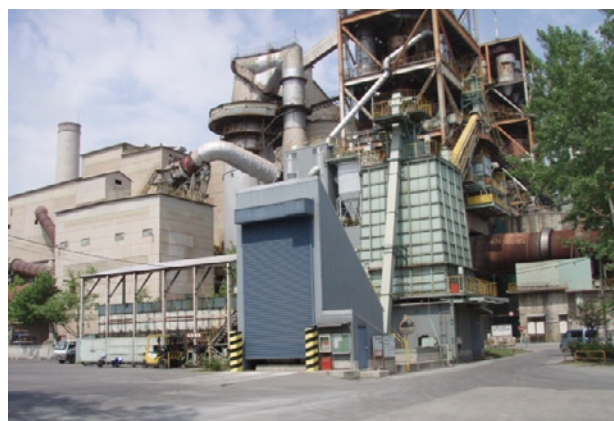
写真13 廃タイヤ・木屑受入れ設備
