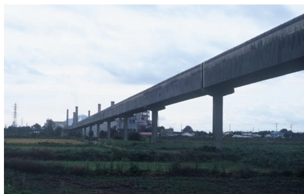
写真3 全長6.2kmのベルトコンベア(G-BC)で石灰石を搬送
