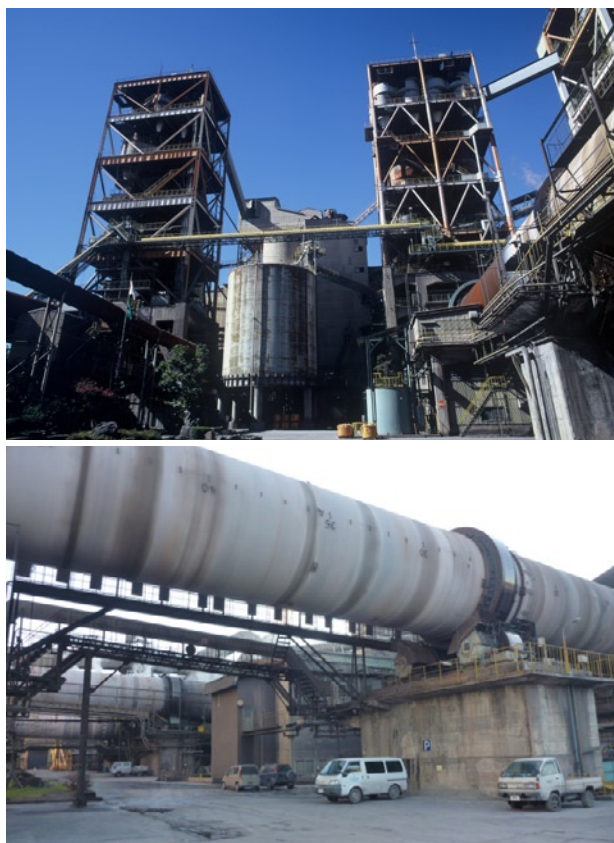
写真5 セメント工場の要・ロータリーキルンが並ぶ
