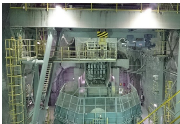
写真8 坑内にある破砕室
