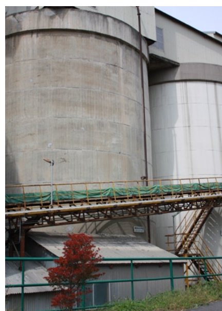
写真2 現在も現役の大正時代に建設されたセメントサイロ
