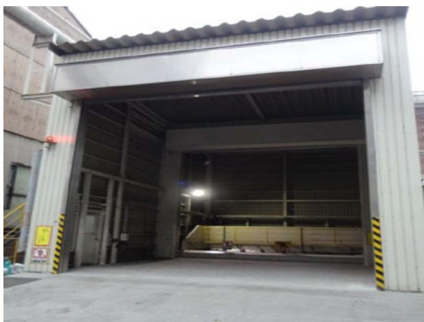
写真8 木質チップ投入設備
