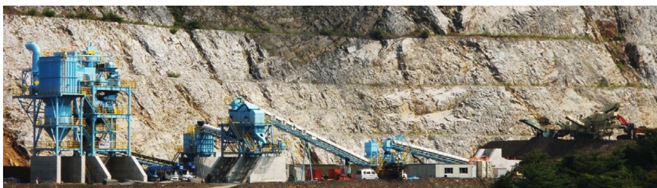
写真9 骨材プラント
