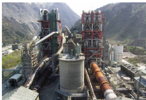
写真3 2基のセメントキルン(4号キルン(左)と3号キルン(右))
