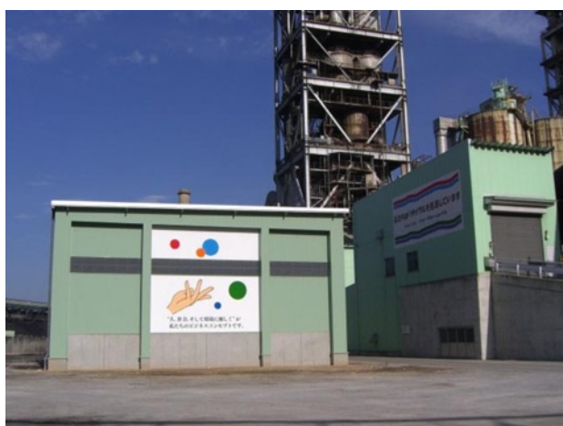
写真5 廃プラスチック類のための建屋(正面)
