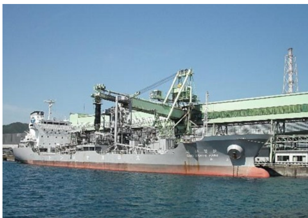
写真2 当社と北陸電力(株)の共同岸壁
