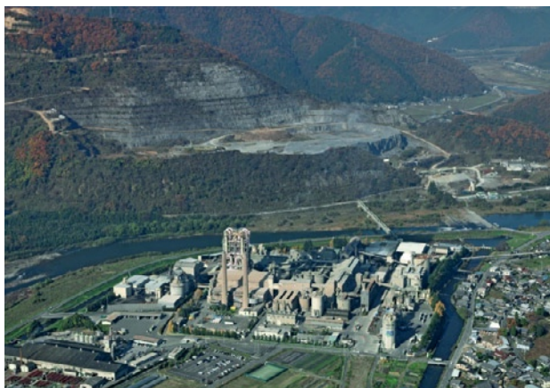
写真1 工場全景と背後に広がる石灰石鉱山
