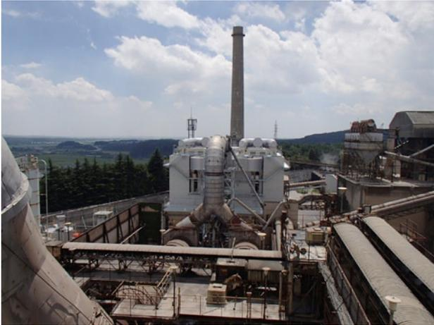
写真7 バグフィルターによる排ガス処理
