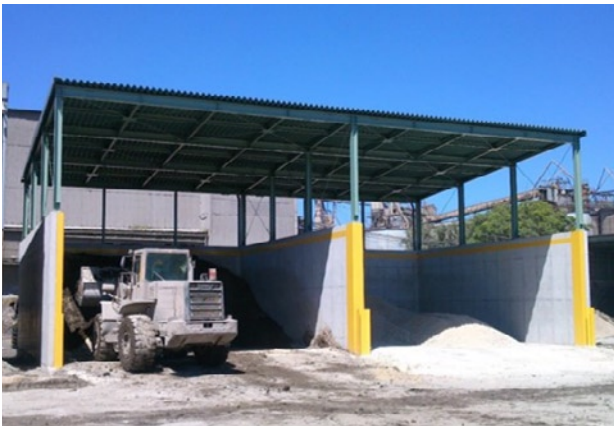
写真7 産業廃棄物貯蔵設備
