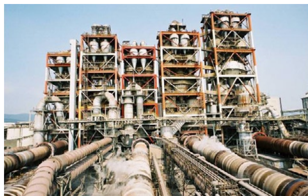
写真3 5基が並ぶロータリーキルンとプレヒーター
