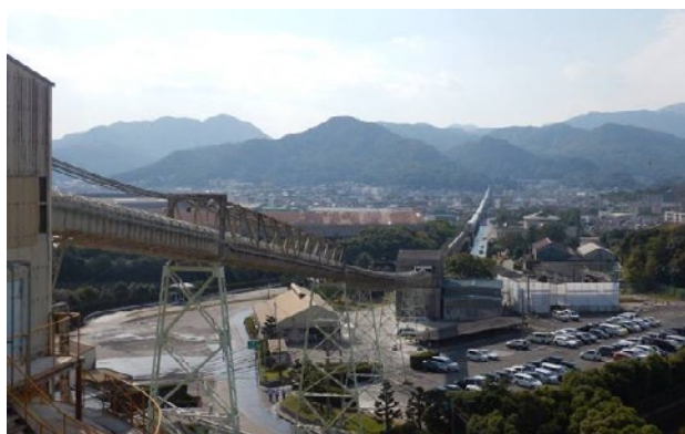
写真2 平尾台から続く平苅ベルトコンベア
