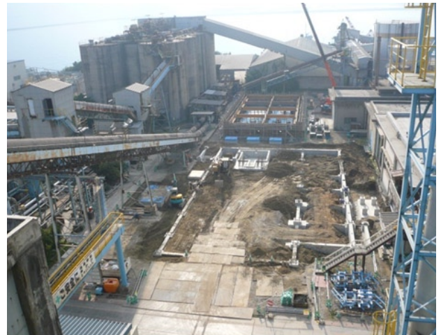
写真4 発電タービン建設予定地
