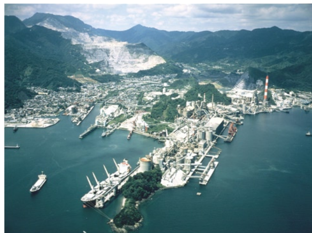
写真2 大分工場全景
