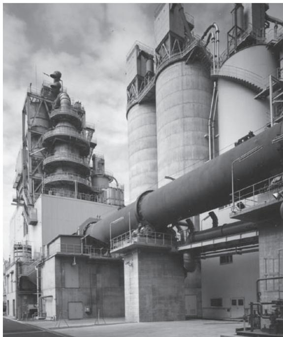
写真3 ロータリーキルンと排ガス冷却塔
