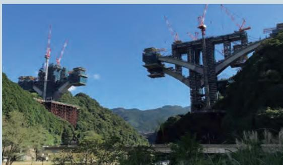
バランスアーチ橋のアーチリブ張出し架設におけるコンクリート施工
