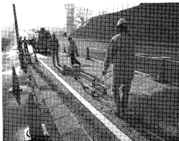
写真 2-11 3m プロフィールメータの測定状況
