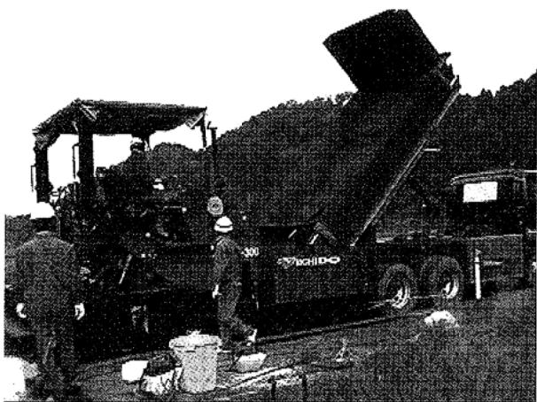
写真 2-4 アスファルトフィニッシャへの
