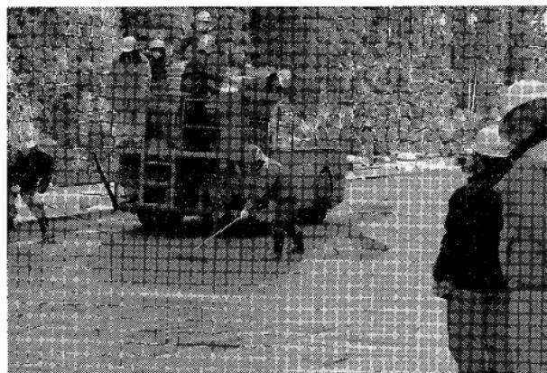
写真 2-13 付着材(セメントペースト)の散布
