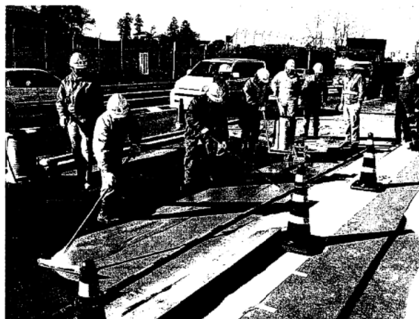
写真 2-3 接着材(ポリマーセメントスラリー) の塗布
