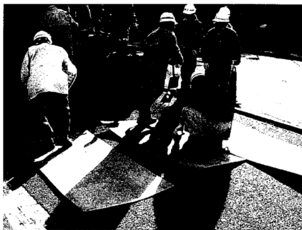
写真 2-5 敷きならしの状況
