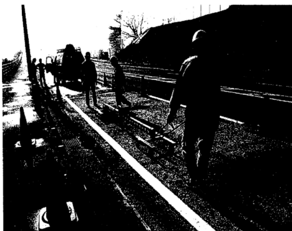
写真 2-11 3m プロフィールメータによる 平たん性の測定状況
