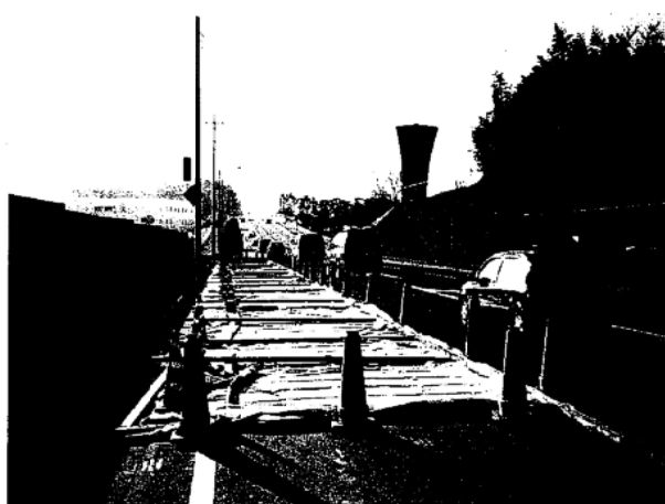
写真 2-7 シートによる養生
