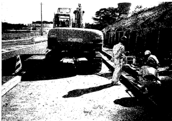
写真 4-16 平板載荷試験状況
