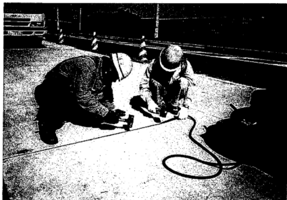
写真 4-14 目地挿入状況
