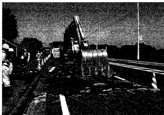
写真 4-2 既設アスファルト舗装の撤去
