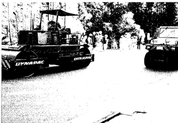
写真 2-12 転圧コンクリートの締固め状況
