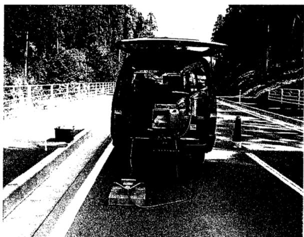
写真 2-22 DF テスターによる動的摩擦係数の測定状況
