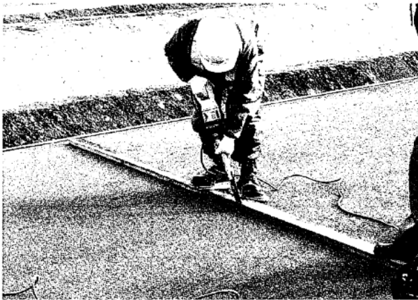
写真 2-5 誘発目地施工
