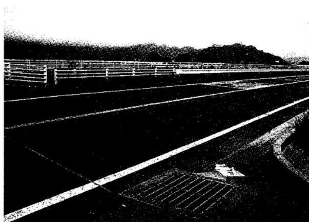
写真 3-2 雨天時のポーラスコンクリート舗装路面 (供用5年時、1時間最大降水量10mmの降雨後)
