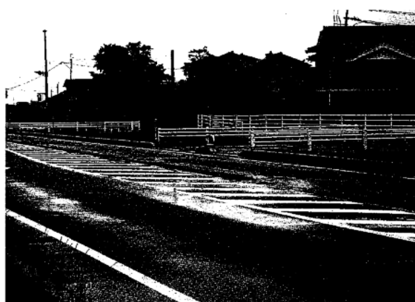
写真 3-3 雨天時の排水性アスファルト舗装路面 (供用5年時、1時間最大降水量10mmの降雨後)
