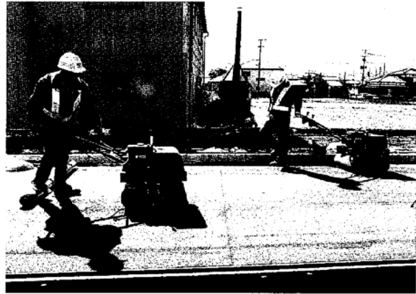
写真 2-4 ハンドガイド式ゴム巻ローラ による補助締固め
