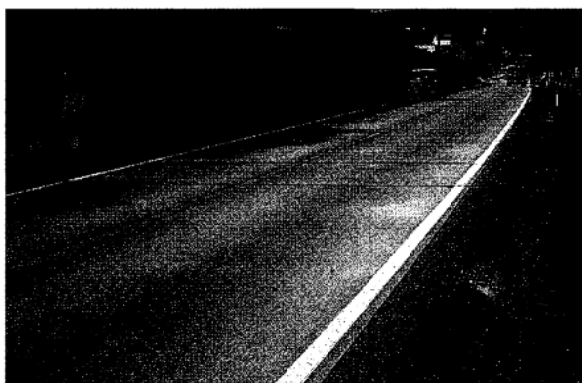
No.24、49号、福島県いわき市、供用39年
