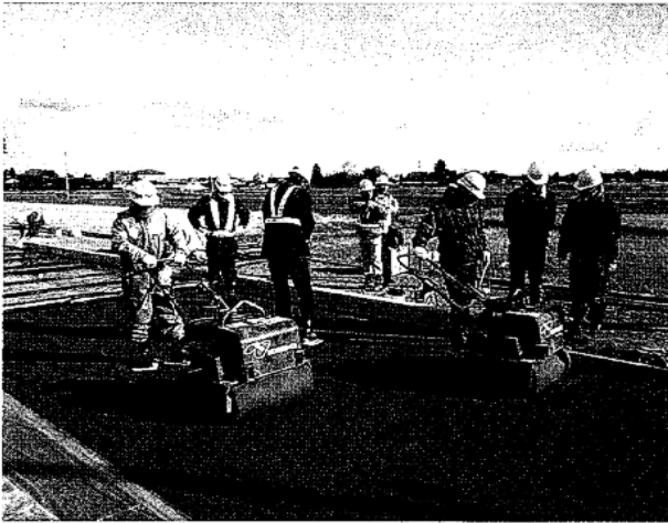
写真2-5 ハンドガイド式ゴム巻ローラによる補助締固め
