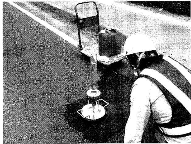
写真 2-12 浸透水量の測定状況
