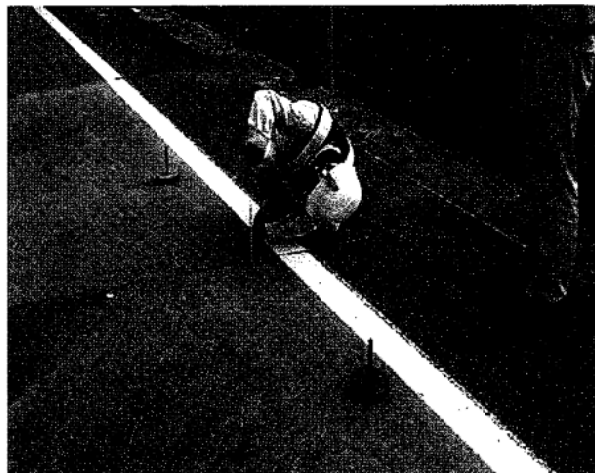
写真 2-15 目地の段差の測定状況
