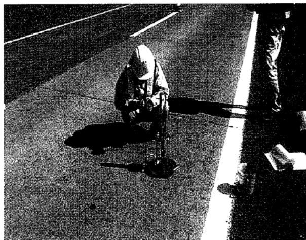
写真 2-14 浸透水量の測定状況
