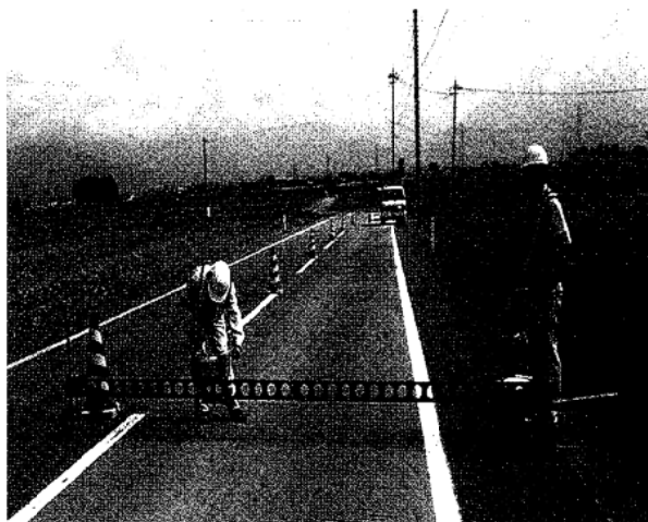
写真 2-12 横断プロフィールメータによる わだち掘れ量の測定状況
