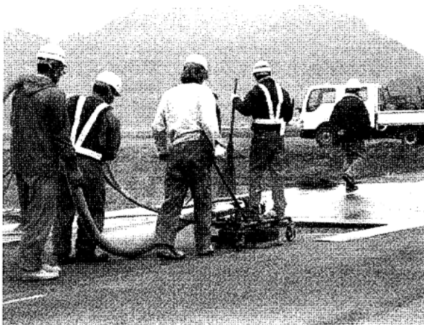
写真 2-4 ウォータージェットによる 切削面表面処理状況
