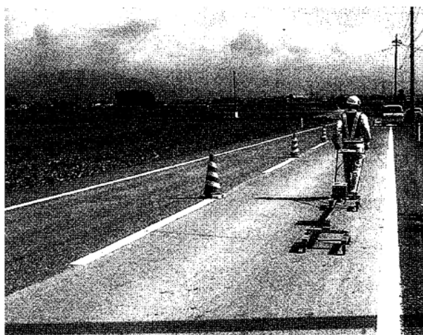
写真 2-11 3m プロフィールメータによる 平坦性の測定状況
