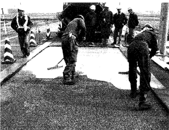
写真 2-6 付着材塗布状況
