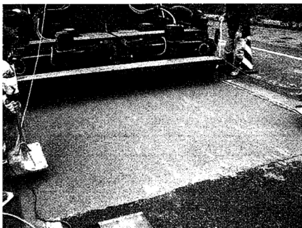
写真 2-8 敷きならし状況
