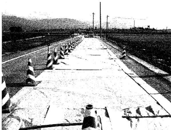
写真 2-9 シートによる養生
