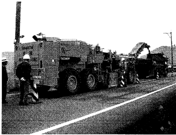
写真 2-2 既設ポーラスコンクリート版切削状況
