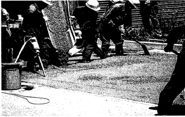
写真 1-8 早期開放用コンクリートの舗設
