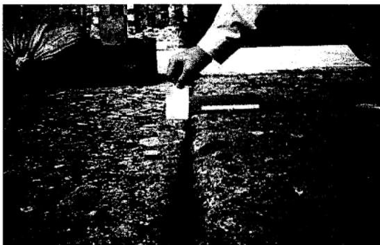
写真 4-5 段差の確認 15mm(No.75-76)
