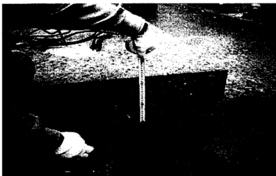
写真 4-7 版厚の確認(健全版 No.84) (版厚 23cm)
