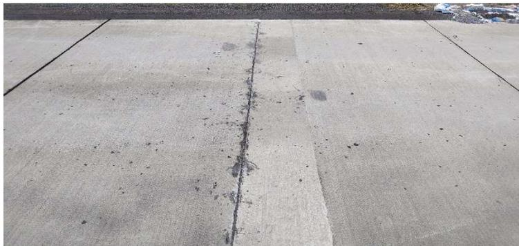
写真-5.12 目視調査結果 (115 万輪走行時点)
