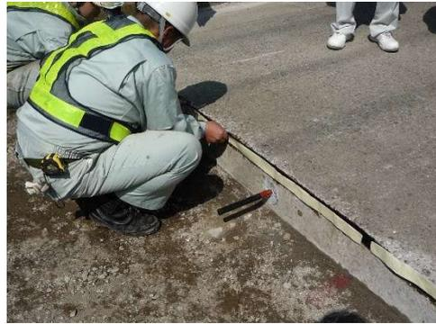
写真-② ウエルバーと目地材の設置
