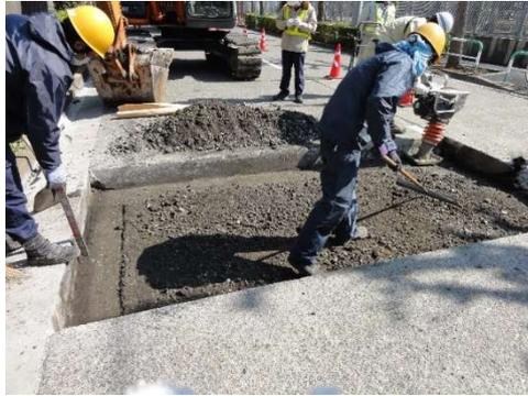
写真-① 補修箇所の解体・撤去
