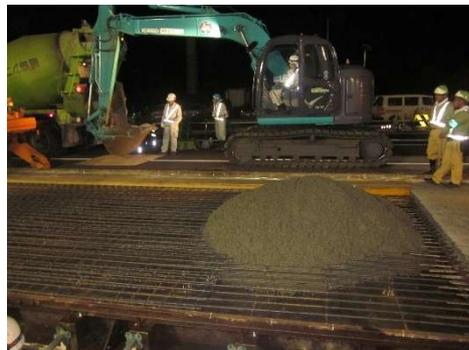
写真-② バックホウによる荷下ろし<sup>43)</sup>
