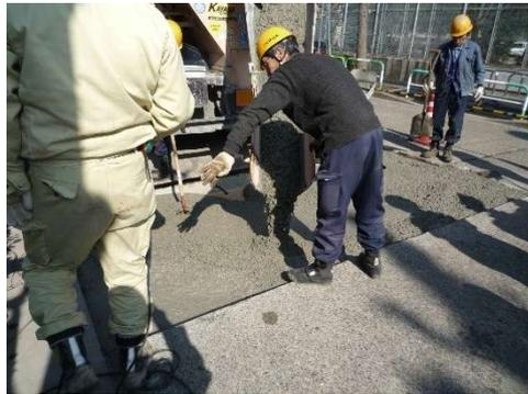
写真-③ コンクリートの打込み
