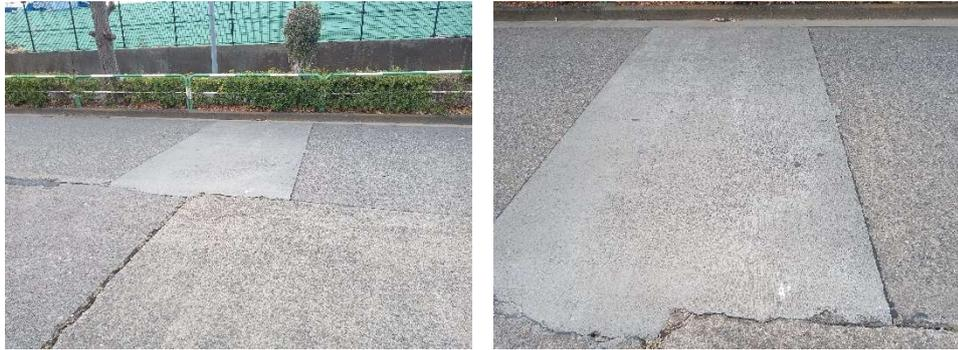
写真-⑥ 供用約 12 年後の補修箇所
