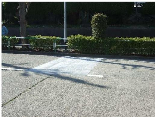
写真-⑤ 交通開放（コンクリートの打込み 24 時間後）
