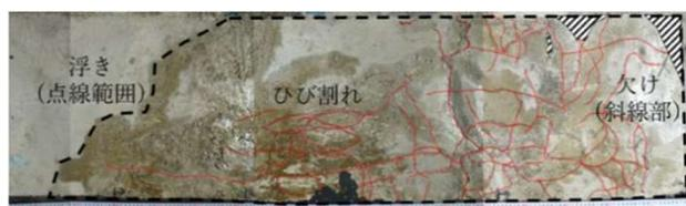
写真-5.4 破損箇所の状況
