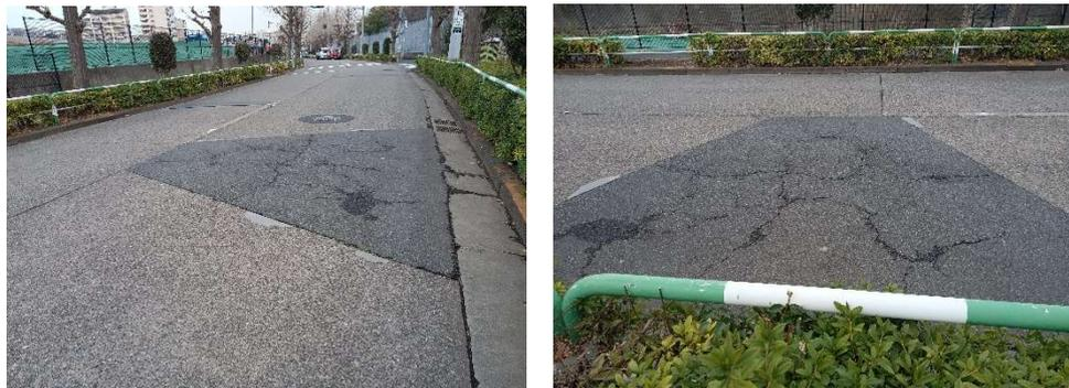
写真-⑧ コンクリート舗装のアスファルトによる切削オーバーレイの供用後
