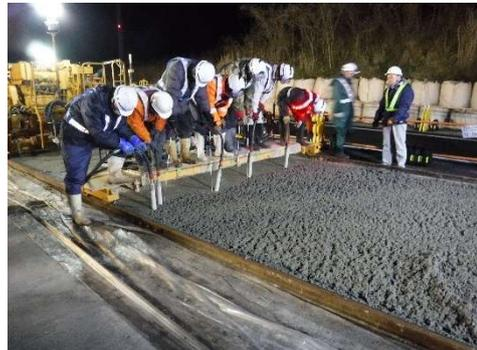
写真-③ 締固め<sup>43)</sup>
