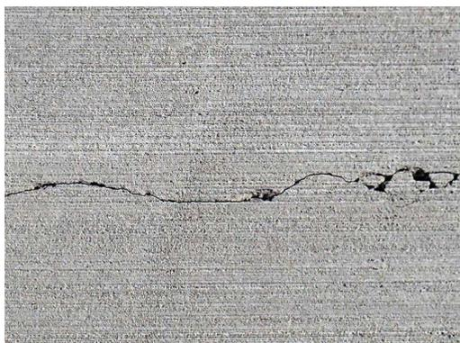
写真-5.19 模擬破損の状況
