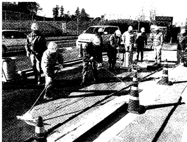
写真 4-2 ポリマーセメントスラリーの塗布状況 8)
