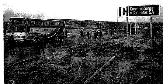
写真2-25 マドリッド市郊外住宅街のバイパス。 RCCの状態で工事用車輛に交通開放されている。
