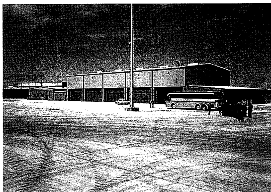
写真4-1 RCCP施工現場。重車輛駐車場の状況。 中央の建物は重車輛の修理場
