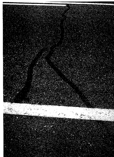
写真2-24 クラックの補修: 歴青材料でシールされている。
