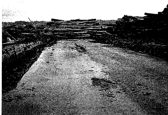
写真5-11 1983年に施工されたと思われるStorage Finger（原木を貯蔵して置く場所）の供用状況。フォークリフトの走行頻度が比較的少ないこともあり、良好な供用状況を示している。
