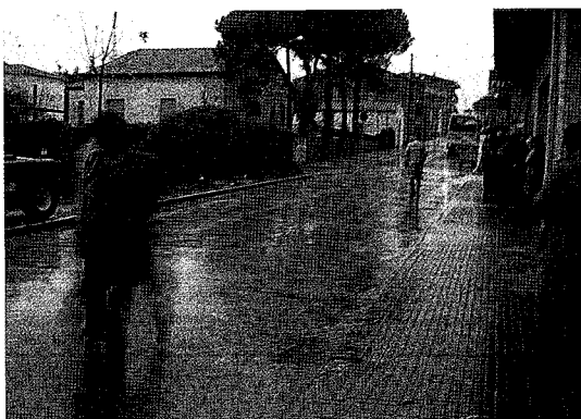
写真2-7 バルセロナ郊外のジナーズの町。住宅地内の道路に使われている。供用性は良いようである。
