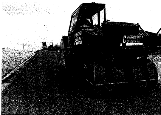
写真2-15 仕上げ転圧に用いているタイヤローラ
