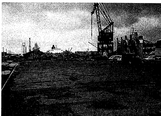
写真3-4 ディエップ港木材ヤードの全景
