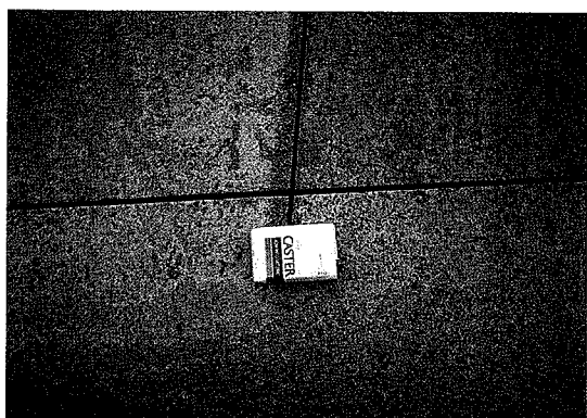
写真2-3 目地状況: 6 m角にカッター目地を設けている。駐機場ということもあってか、特にシールはされていない。
