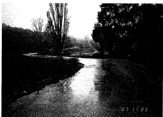
写真2-5 1986年に施工されたバルセロナ農道。 6 m間隔でカッター目地が設けられている。表面状況は良好である。
