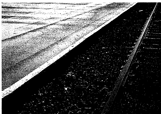
写真4-15 RCCP側端部の状況(写真4-14の右端)
