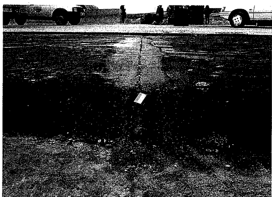
写真2-17 舗設後1~2日間散水養生を行い、アスファルト乳剤で表面処理を施している。カッター目地間隔は15mである。
