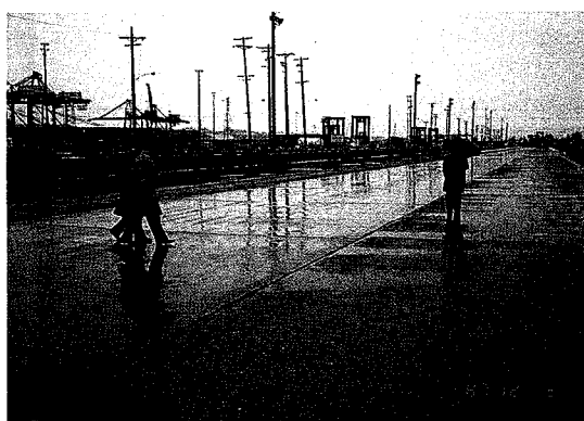
写真4-17 タコマ港インターモダルヤード北地区RCCP施工現場全景
