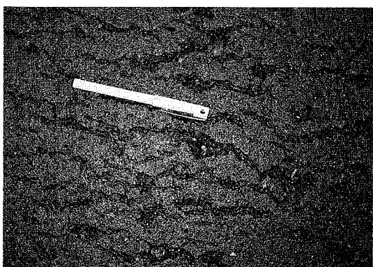
写真5-7 表面性状:フィニッシャの引きずり跡が見られる。
