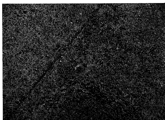
写真2-26 表面性状: 乳剤と散砂で表面処理が行われている。表面の肌目が粗いが、平坦性は良い。
