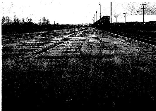
写真4-14 タコマ港インターモダルヤード南地区RCCP施工現場全景
