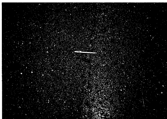
写真4-16 表面性状:中央の縦すじは縦方向フレッシュジョイント部
