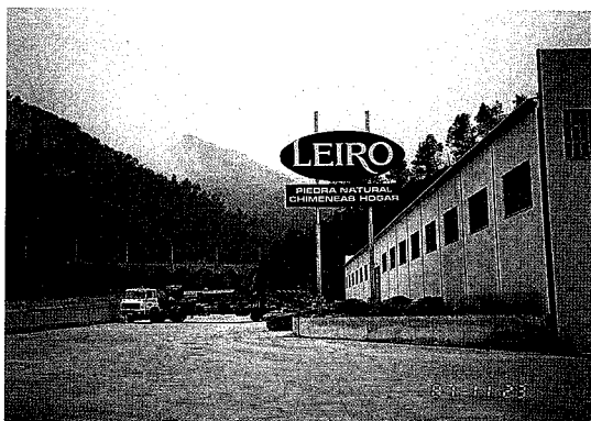
写真2-1 LEIRO社構内舗装の全景。 約2,000㎡にRCCPを施工している。
