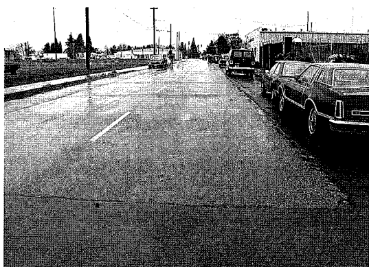
写真4-11 マルトノマー郡道路・RCCP施工現場の状況
