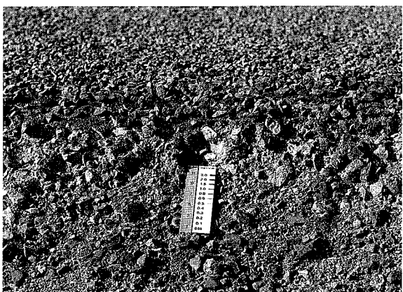
写真 2-5 チップシール舗装はCTBの下層路盤、粒状の上層路盤、その上に15mm程度の碎石を2層に使用したチップシールが施してある。
