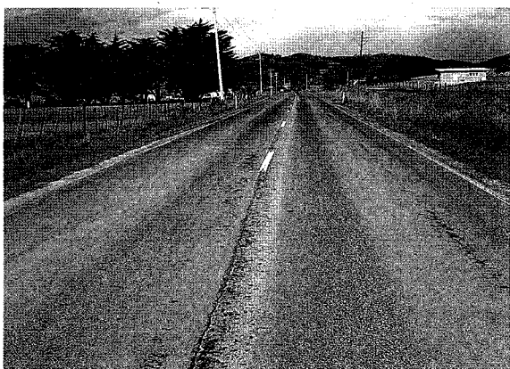
写真 6-3 全長800mの2車線道路における試験施工、RCCP (15cm) によるオーバーレイで即日開放である。
