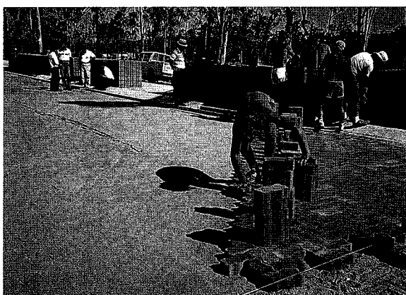
写真7-3 ブロックの舗設状況。
