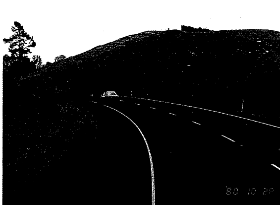
写真 9-4 ニュージーランドのモータウェイ、牧場地帯を走っている、ほとんどチップシール舗装である。
