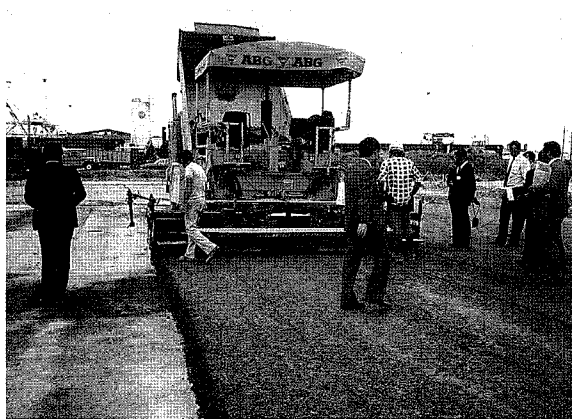
写真 4-4 ABG社のフィニッシャを使用したCTB舗設状況、この後10t級振動ローラで転圧。
