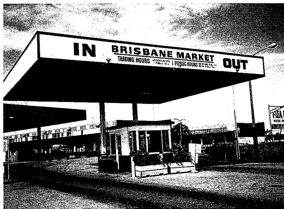
写真7-6 アスファルト舗装でワダチ掘れが生じ、CTB+ILBで舗装し良好な結果を得ている市場のゲート付近。
