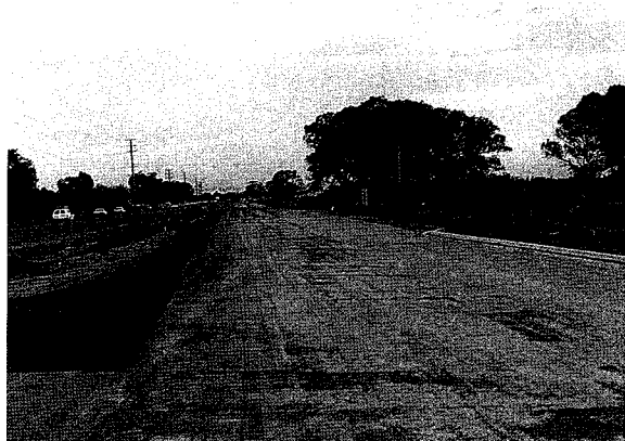
写真 5 - 1 1kmに及ぶRCCPの試験施工現場。
