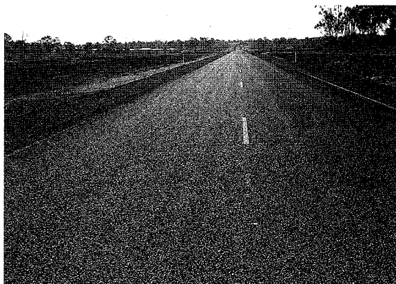
写真 2-1 オーストラリアで最初の有料道路、全長32kmで現在建設中。
