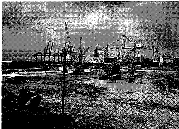
写真 4-1 CTB, RCCP施工現場の全景とRCCプラント。
