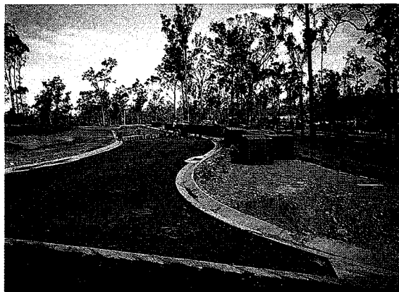
写真7-2 分譲住宅地の道路、粒状路盤のうえにプライムコートを行ってILBを舗設する。
