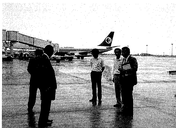
写真 8-5 エプロン部のコンクリート舗装、スリップフォームペーパーによる舗装であるが平坦性はあまり良くない。
