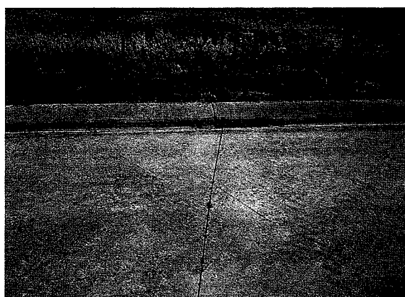
写真 5 - 3 走行性の改良と振動の低減を目的として斜めに入れたカッター目地。
