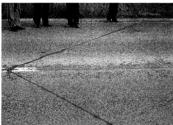
写真 6-6 極端な斜めジョイントを試みたが先端部に角かけが生じた。
