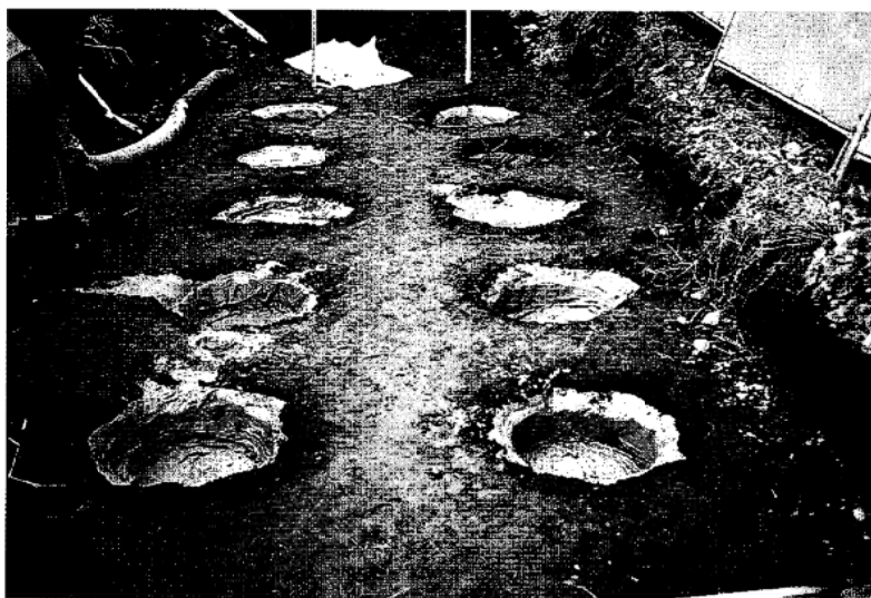
写真－1.8 改良土の充填完了の状態
