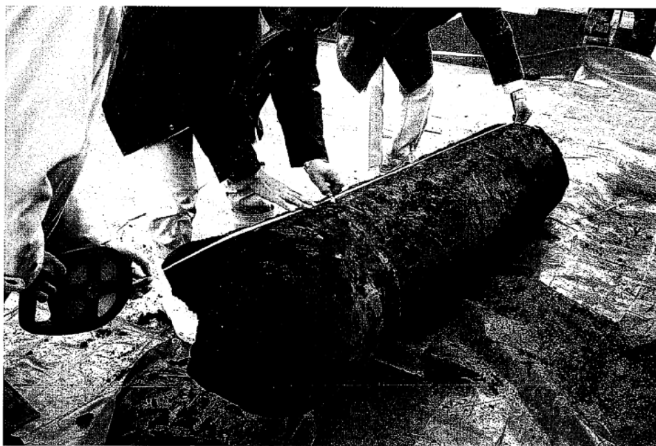
写真－2.3 改良体出来型の測定
