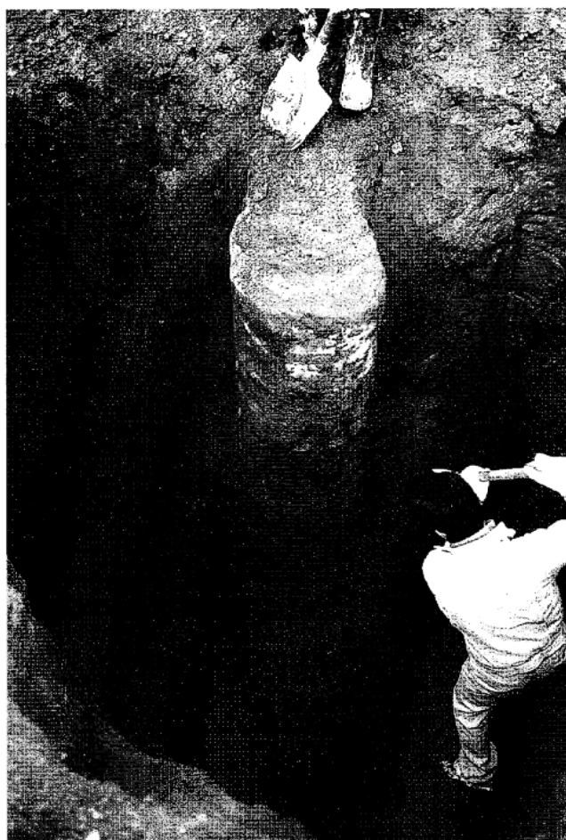
写真－２.２ 一部手作業による
