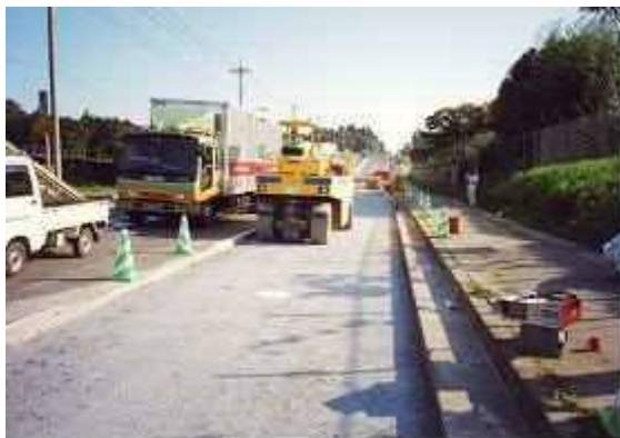
写真 4-5 路盤の転圧状況
