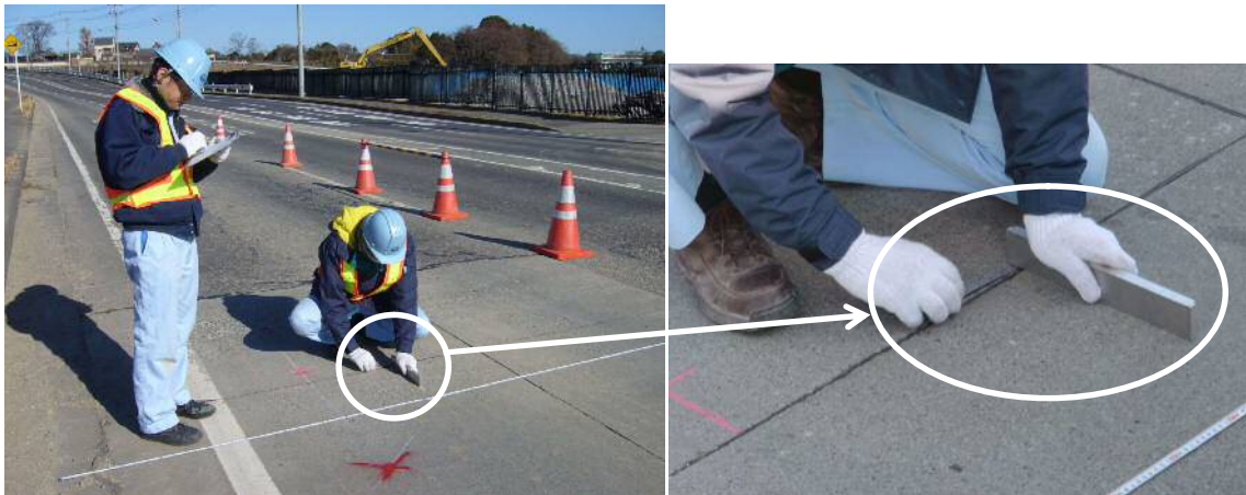
写真 5-2 目地部の段差の測定状況
