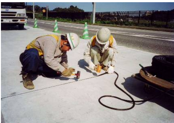
写真 4-16 ガスケット目地挿入状況
