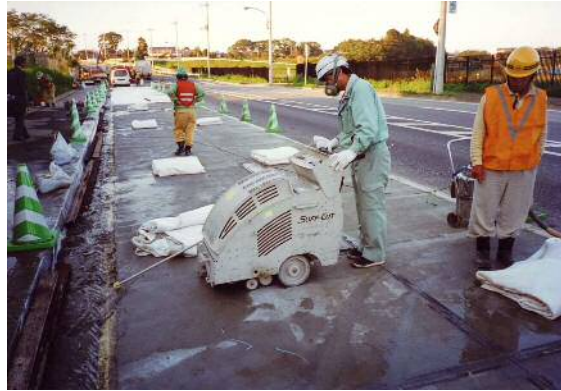
写真 4-15 カッタ目地切りの状況
