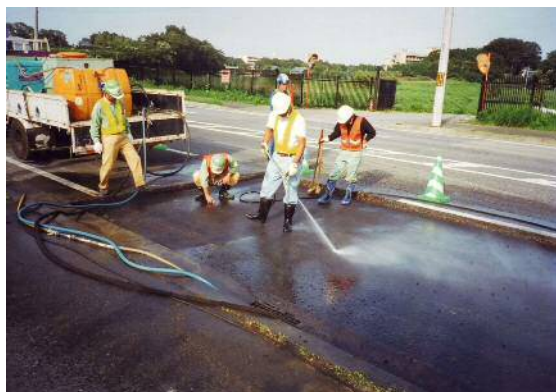
写真 4-11 表面洗浄状況
