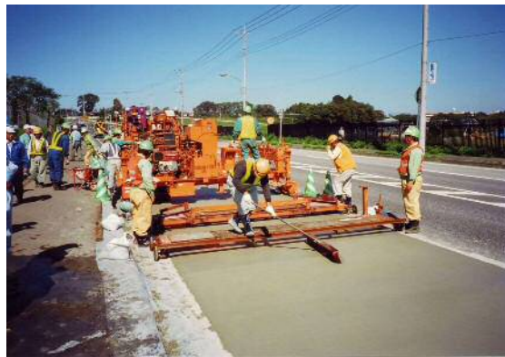
写真 4-13 ほうき目仕上げ状況
