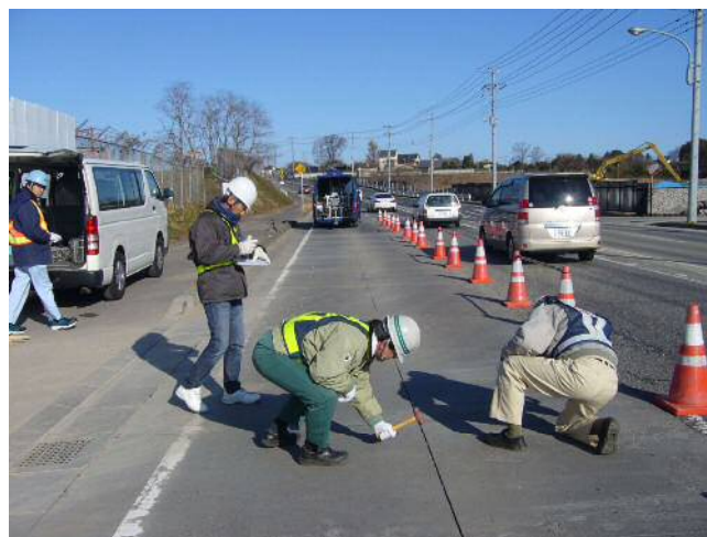
写真 5-3 打音法による剥離、浮きの測定状況
