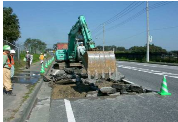
写真 4-4 既設 As 舗装の撤去状況
