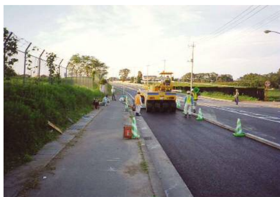
写真 4-9 二次転圧状況
