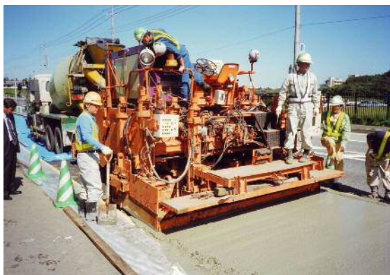
写真 4-12 コンクリート打設状況
