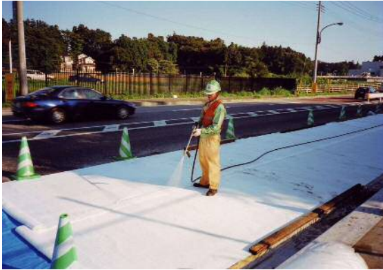
写真 4-14 湿布養生状況
