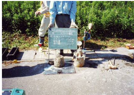
写真 4-20 生コンの試験状況
