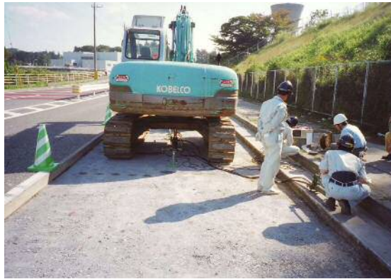
写真 4-18 平板載荷試験状況
