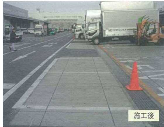
写真 1-2 WT 工法の適用事例(トラックターミナル)
