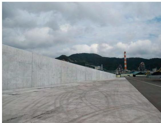
写真 3.5.4 既設防潮堤の嵩上げ状況 (大船渡港海岸) <sup>5)</sup>
