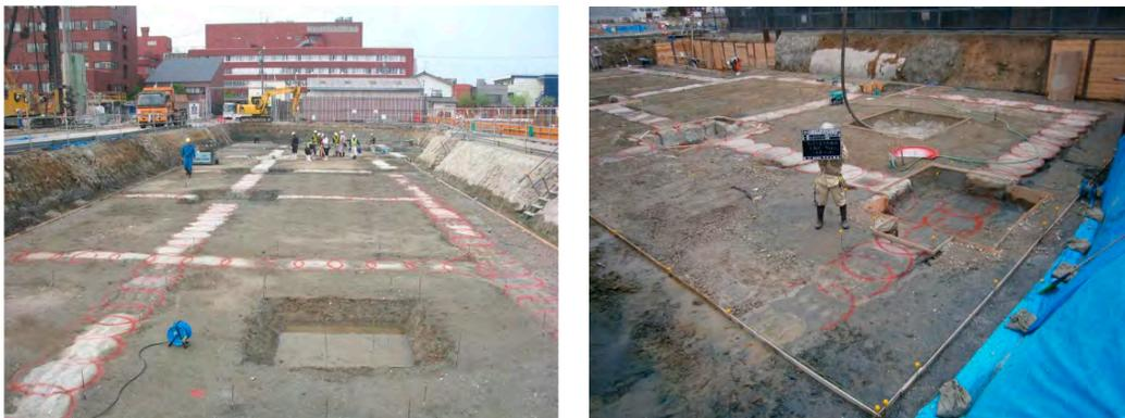
写真 4.12.6 地盤改良体の天端の状況
