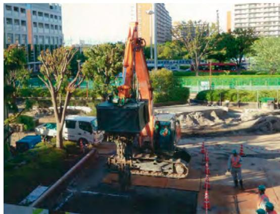
写真 3.3.3 浅層混合処理の状況
