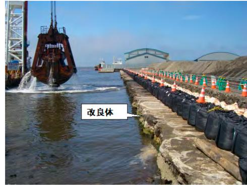
写真 4.6.1 旧岸壁の取り壊し・掘削状況<sup>1)</sup>
