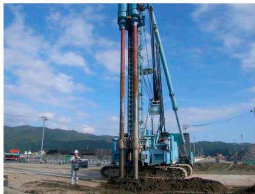
写真 3.5.2 地盤改良の状況（大船渡港海岸）<sup>4)</sup>
