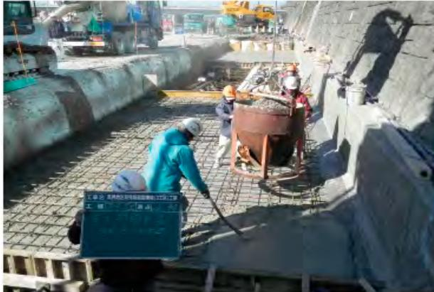
写真 4.4.3 フーチングコンクリート施工状況
