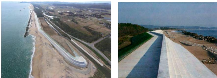
写真 3.7.3 CSG 海岸堤防完成状況<sup>3)</sup>
