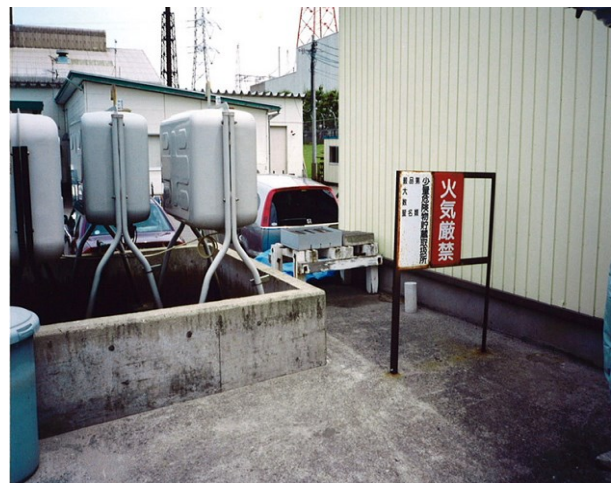
写真 2.1.13 曝露状況(曝露開始～材齢 22 年)
