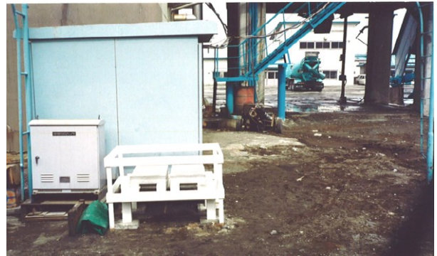
写真 2.1.5 曝露状況(曝露開始～材齢 15 年)
