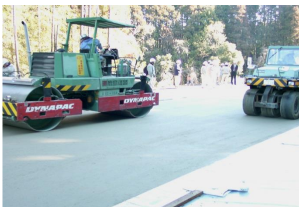
写真 2-12 転圧コンクリートの締固め状況
