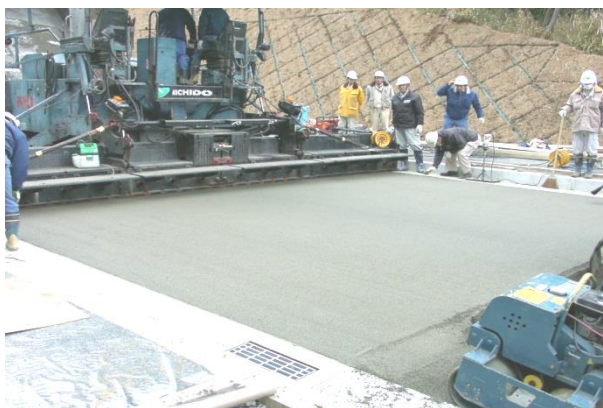
写真 2-4 敷きならし状況
