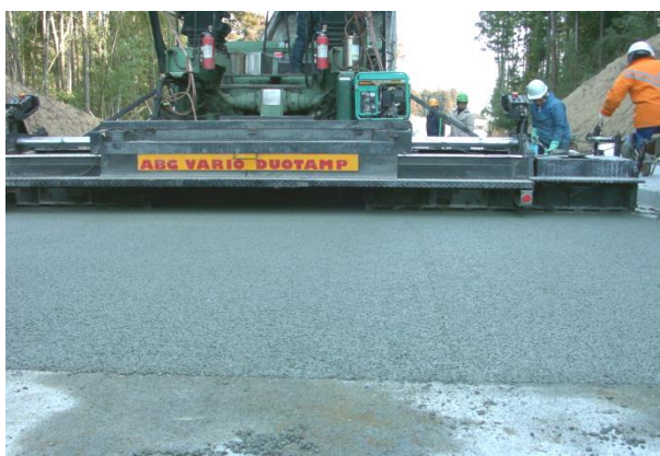
写真 2-16 敷きならし状況
