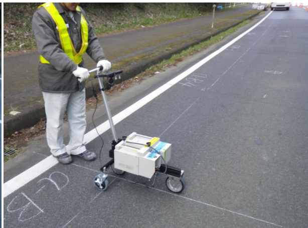
写真 2-22 わだち掘れの測定状況
