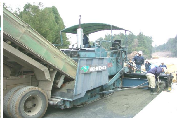
写真 2-3 アスファルトフィニッシャへの ポーラスコンクリートの荷卸し
