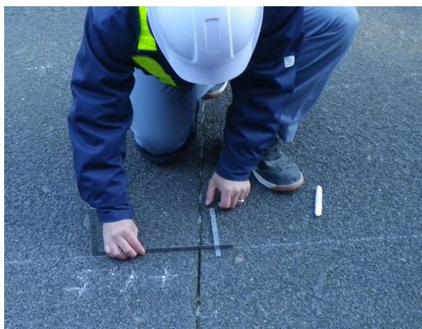
写真 2-24 目地の段差の測定状況
