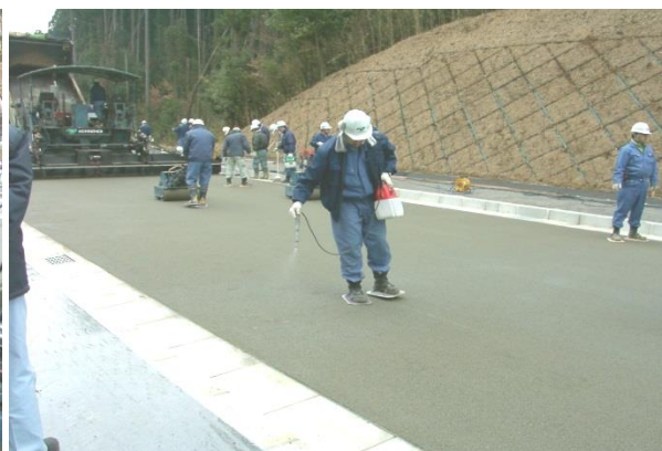
写真 2-5 養生剤の散布状況
