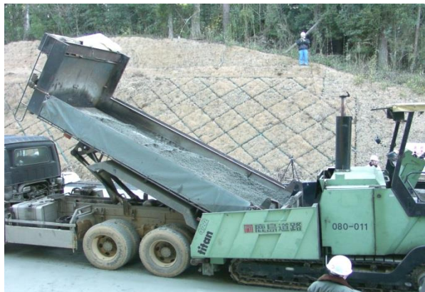
写真 2-15 アスファルトフィニッシャーへの ポーラスコンクリートの荷卸し
