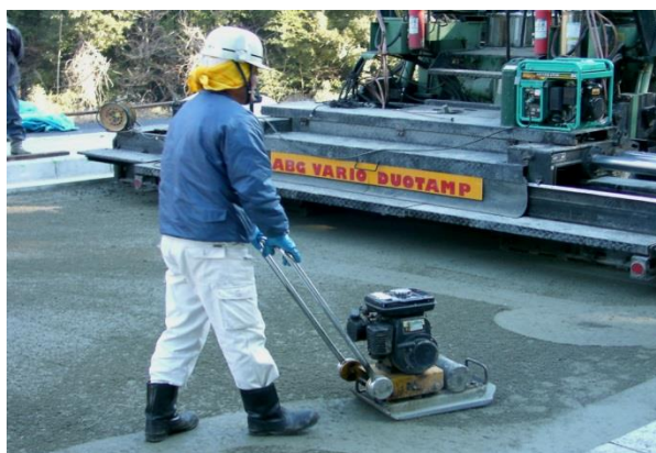
写真 2-11 転圧コンクリートの 敷きならし状況
