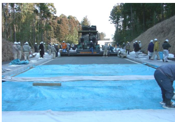
写真 2-17 シートによる養生
