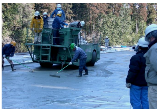
写真 2-13 付着材(無収縮モルタル)の散布
