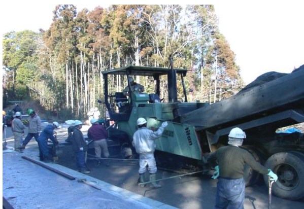
写真 2-10 アスファルトフィニッシャへの 転圧コンクリートの荷卸し
