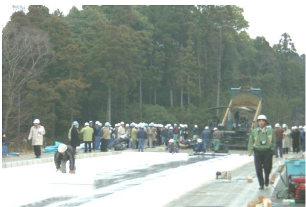
写真 2-6 シートによる養生
