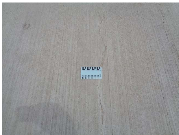
写真 1-4 CRCP に発生したひび割れ（0.3mm 以下に制御）
