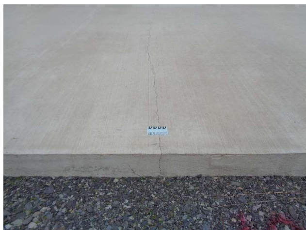
写真 1-5 CRCP に発生したひび割れ（幅の広いひび割れ）
