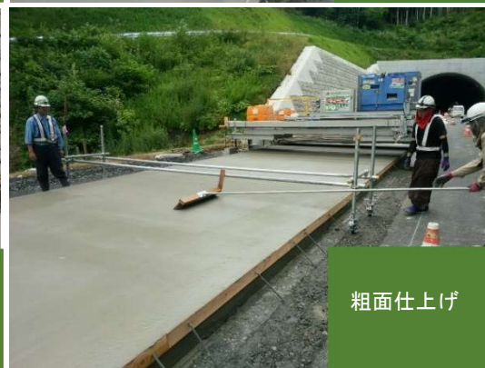
写真 1-2 スリップフォームペーパでの施工状況
