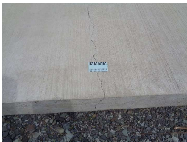
写真 1-5 CRCP に発生したひび割れ（幅の広いひび割れ）
