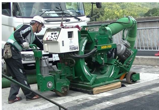
写真-5 床版研掃工
