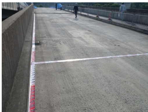
写真-4 既設アスファルト舗装切削後
