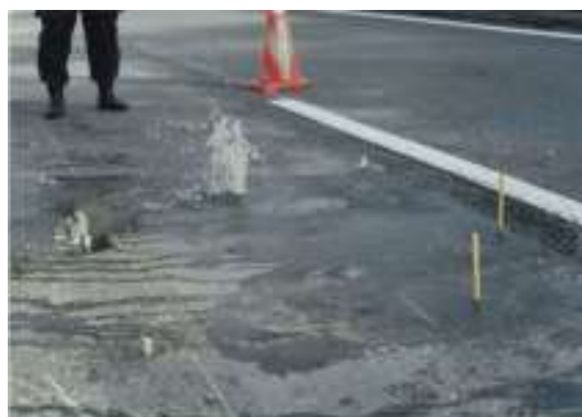
写真-37 本来の洗浄状況例（他現場）
