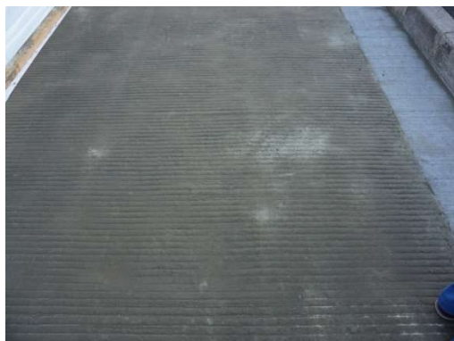
写真-31 路面の様子（施工後 2 日）
