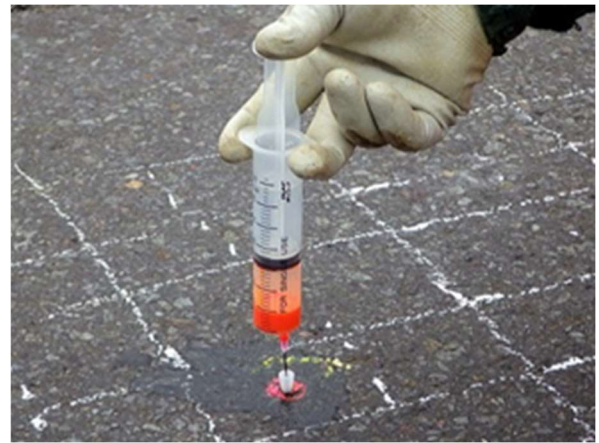
写真-18 特殊カラー樹脂注入
