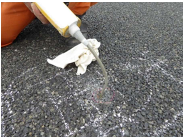
写真-21 検査後の検査孔の穴埋め充填
