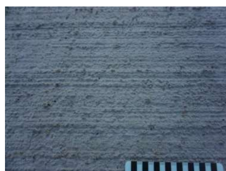
写真－30 間詰部の箒目仕上げの様子
