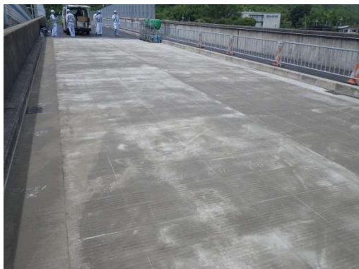
写真-14 施工終了（8月10日）
