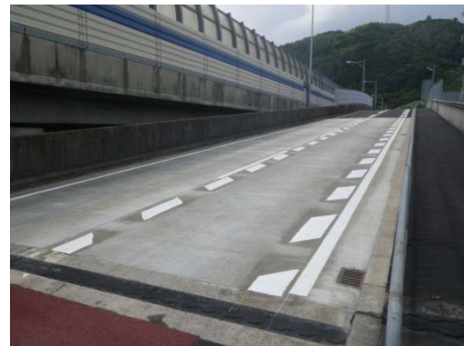
写真-15 供用中（9月3日）
