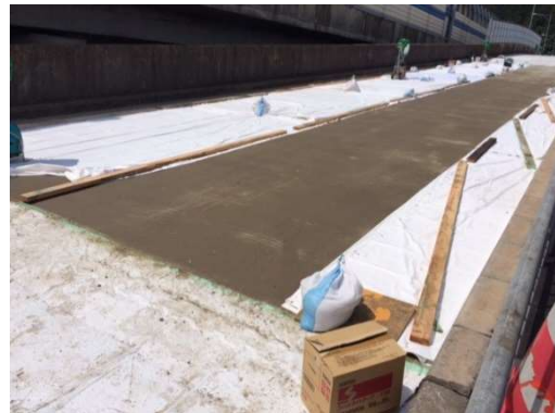
写真-13 養生工（上り車線と下り間詰、 下り車線は養生終了）
