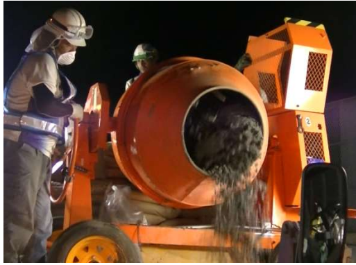
写真-8 コンクリートの練混ぜ
