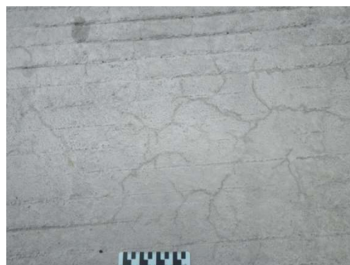
写真-32 路面の様子（施工後 3 週間）
