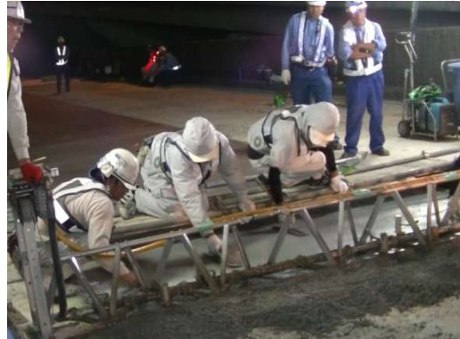
写真-11 表面均し
