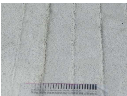
写真-33 路面の様子（施工後 2 週間）
