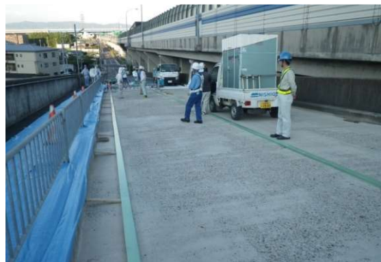
写真-7 型枠設置
