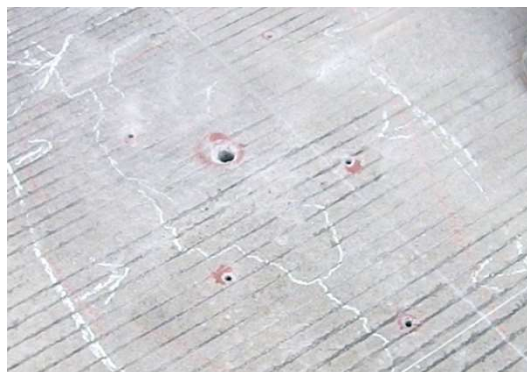
写真-36 削孔完了状況
