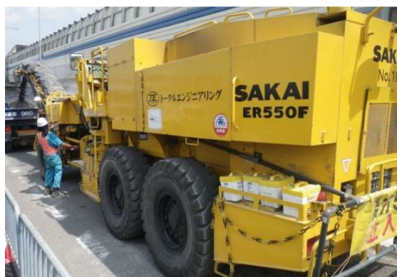
写真-3 既設アスファルト舗装切削工
