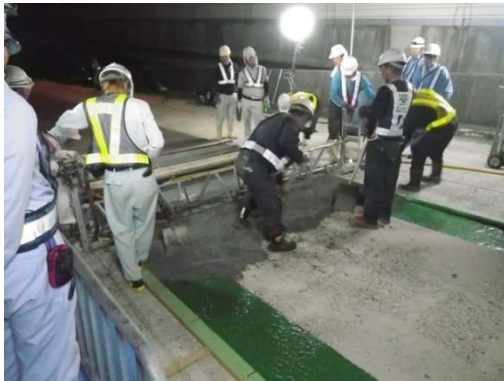
写真-10 接着剤塗布および打込み
