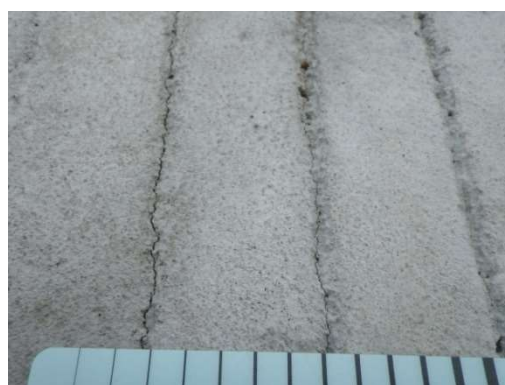
写真-34 路面の様子（施工後 3 週間）
