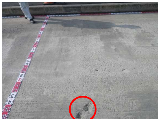
写真－27 既設 RC 床版の様子
