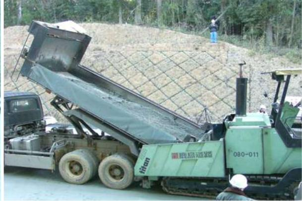
写真-2.15 アスファルトフィニッシャへの
