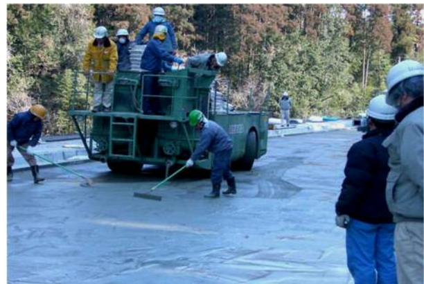
写真-2.13 付着材(無収縮モルタル)の散布
