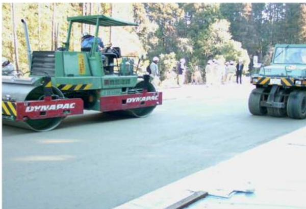
写真-2.12 転圧コンクリートの締固め状況
