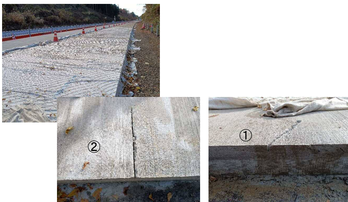
写真-3.1 施工区間と ACC（①斜めノッチ、②直角ノッチ）
