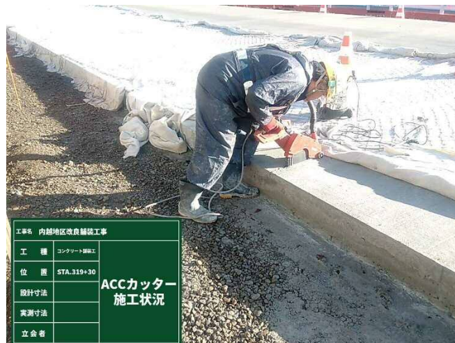
写真-3.2 ACC カッター施工状況
