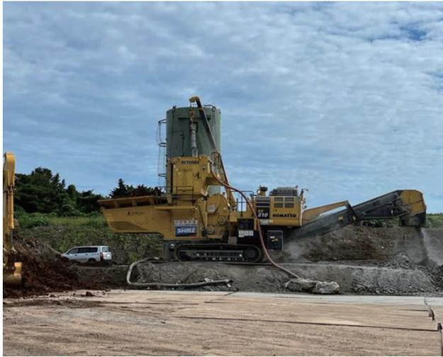
写真4 崩落土砂改良の様子
