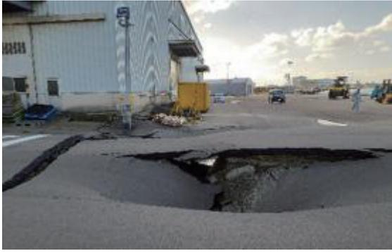
写真3 御供田ふ頭の被害の様子
