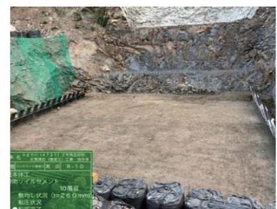
写真8 本體工・転圧完了
