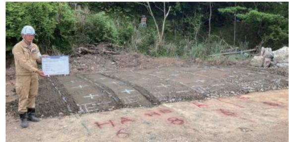
写真5 試験施工ヤード・転圧完了
