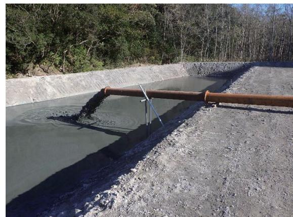
写真10 濃縮土の圧送・貯蔵状況
