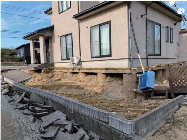
写真3 内灘町の住宅の柱状改良<sup>1)</sup>
