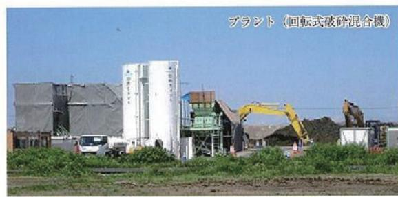
(a) 原土と固化材の混合状況
