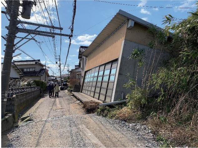
写真1 内灘町の倉庫の隆起破壊
