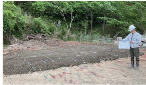
写真3 試験施工ヤード・敷均し完了
