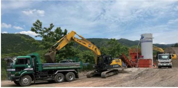
写真2 INSEM 材製造プラント・運搬状況
