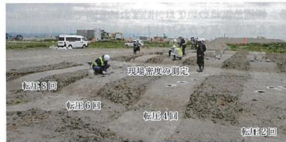
(c) 試験転圧および現場密度測定状況
