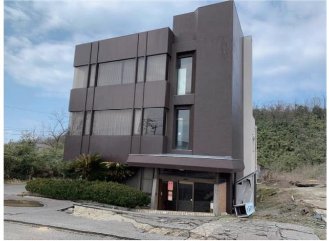
写真2 内灘町の建物の約1mめり込み沈下
