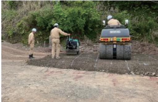
写真4 試験施工・転圧状況
