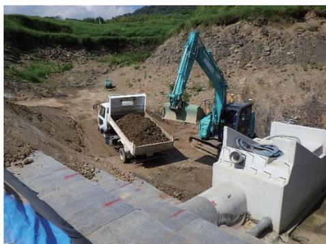
(c) 改良した盛土材の運搬
