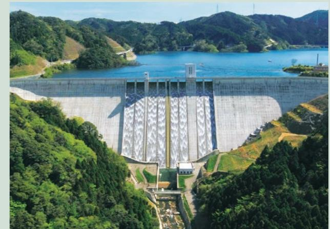
五ヶ山ダムは、1978年および1994年に起きた異常渇水への対策等を目的として2018年に完成した多目的ダム。福岡市中心部を流れて博多湾に注ぐ那珂川上流に位置し、水道用水の供給といった利水や河川の正常な機能の維持等の洪水調節も行う。一方、有効貯水量3,970万m<sup>3</sup>のおよそ半分にあたる1,660万m<sup>3</sup>は、10年に一度の規模を超える異常渇水時に備えて温存されることで「貯める」力を発揮する。
