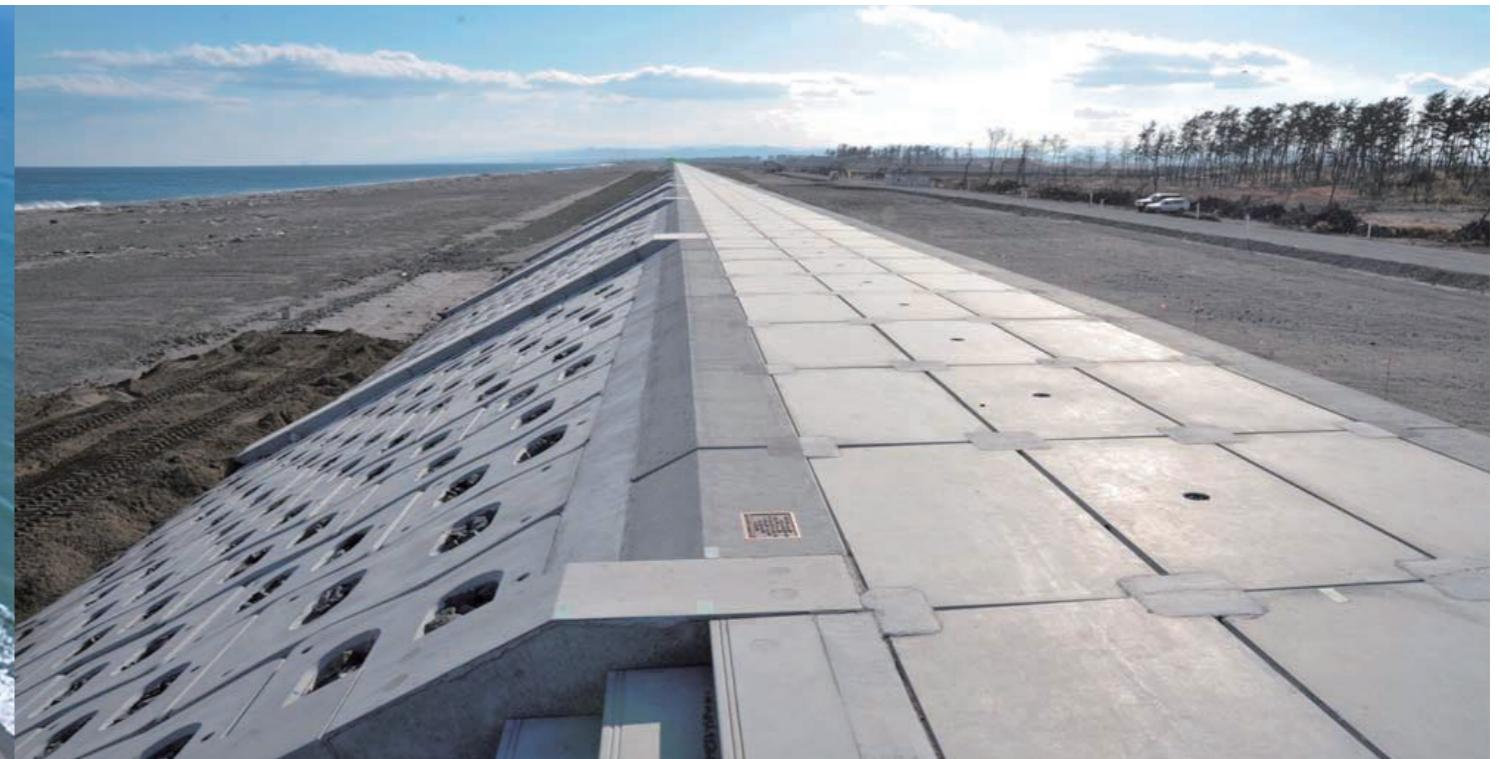
宮城県仙台市から福島県境までの3市2町にまたがる延長約65kmの仙台湾南部海岸。東日本大震災で被害を受けた海岸堤防の復旧整備事業では、将来への備えとして粘り強い海岸堤防の構築が行われた。完成した約46kmの堤防は、東日本大震災級の巨大津波(約14m)に対して、浸水面積は約半分まで軽減。退避時間を5分稼ぐことができるとして試算されている。一方、海岸堤防高さ相当の津波(約7m)に対しては、整備前に約8,500haあった浸水面積が整備後にはほぼ解消が可能となり、比較的頻度の高い津波(約5m)では整備前に約2,600haあった浸水面積が解消されることだ。
