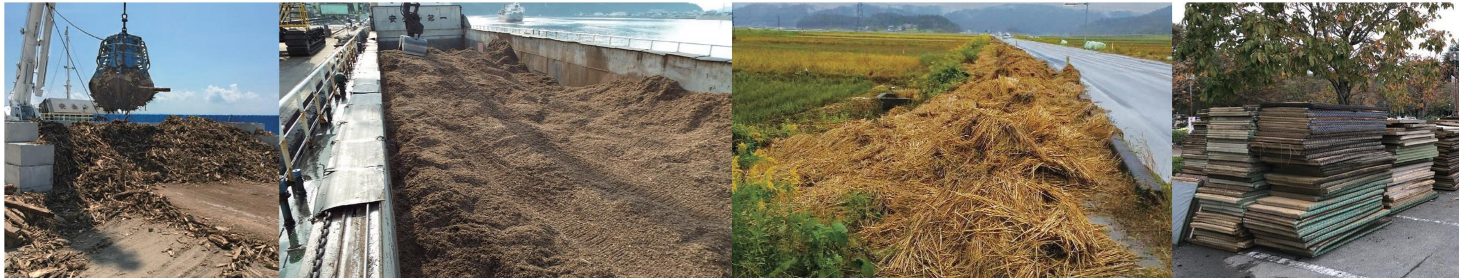
2016年に発生した熊本地震では、震度7の激震が同一地区を2度襲った。この地震により、県内の8,000棟を超える住戸が全壊。300万tを超える災害廃棄物が発生した。県では同年の豪雨による住宅被害も抱えており、膨大な量の災害廃棄物が長期間にわたり発生することとなった。セメント協会は、環境省の「D.Waste-Net」を通じて災害廃棄物処理への支援依頼を受け、協会加盟社による災害廃棄物処理を開始。廃棄物はセメント製造の原料や熱エネルギー源として利用され、復旧復興のためのセメントとして同県内に供給された。その供給量は災害後3年間で150万tにのぼり、復旧復興に役立てられた。
