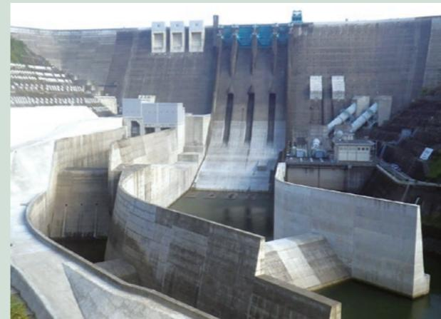
鶴田ダムは、洪水調節と水力発電を目的に1965年に完成した多目的ダム。川内川の中流部に位置し、2018年に完了した再開発事業により洪水調節容量が1.3倍にアップした。2020年7月の大暴雨では、ダム上流域で累加雨量403.7mm（7月5日8時～7月8日5時）を観測するなか、約36,588千m<sup>3</sup>の洪水を貯留。もしダムが整備されていなければ、ダム下流の宮之城地点水位は約1.87m上昇し、はん濫危険水位を超えていたと推定される。
