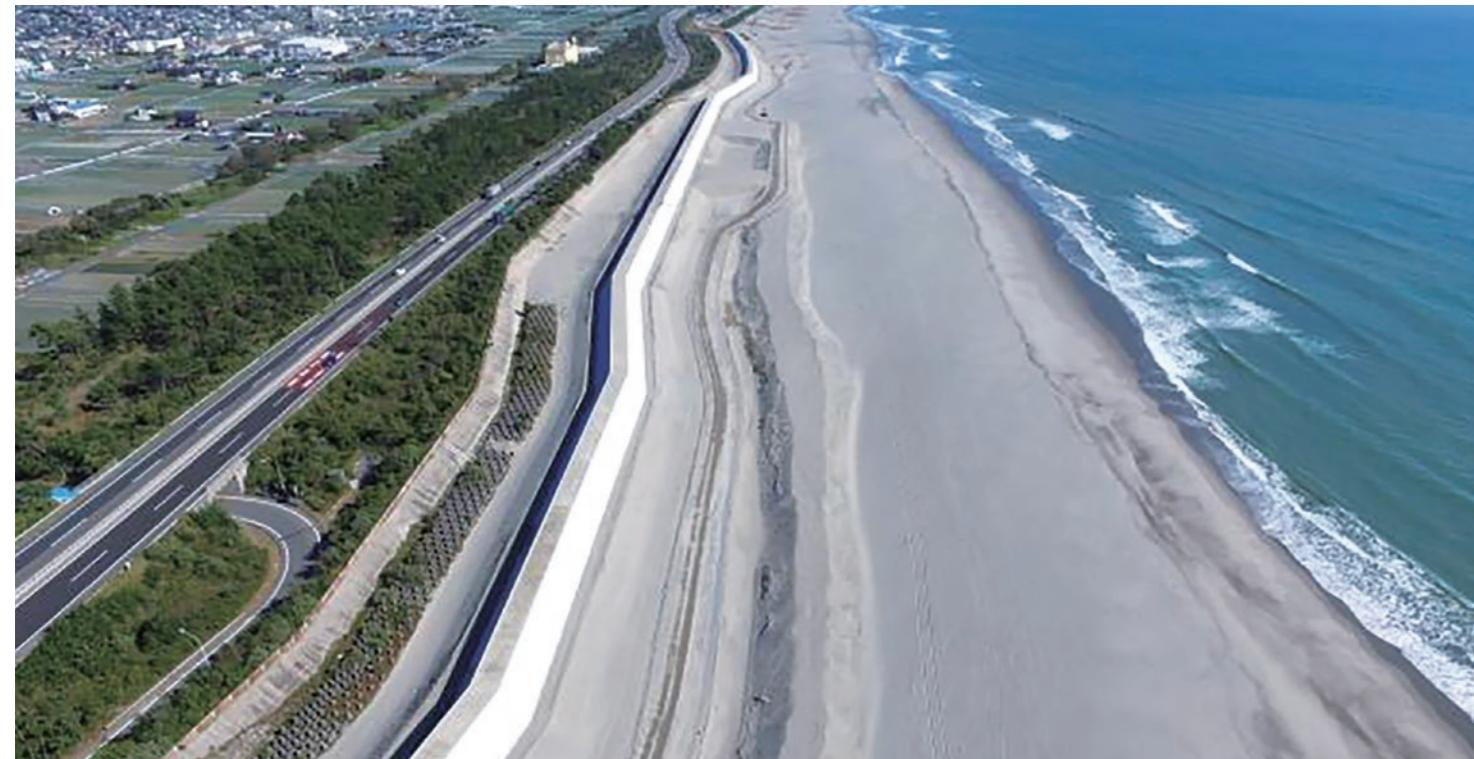
南海トラフ地震に備えた防災インフラ整備が進む静岡県。浜松市沿岸域防潮堤整備事業はそのひとつで、地元の材料とマンパワーへのこだわりが特徴だ。ダム建設から生まれたCSG (Cemented Sand and Gravel) 工法を採用し、工期の短縮とコストの削減、そして防潮堤の強度向上を実現。総延長17.5km の全区間に防潮堤が完成した。これによりレベル1<sup>\*1</sup>および2<sup>\*2</sup>の津波が発生した場合、整備前に比べて宅地浸水面積を約8割低減でき、かつ宅地浸水深2m以上の範囲を98%低減する効果が見込まれている。
