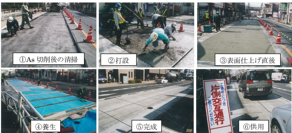
写真-1 施工フローの一例
