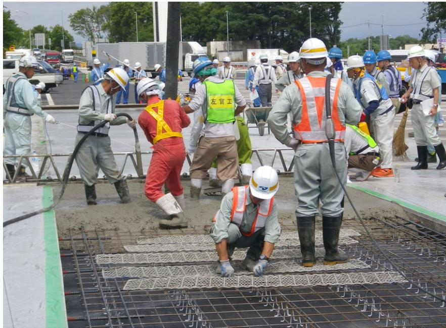
図 6-2-46 打込みおよび締固めの様子
