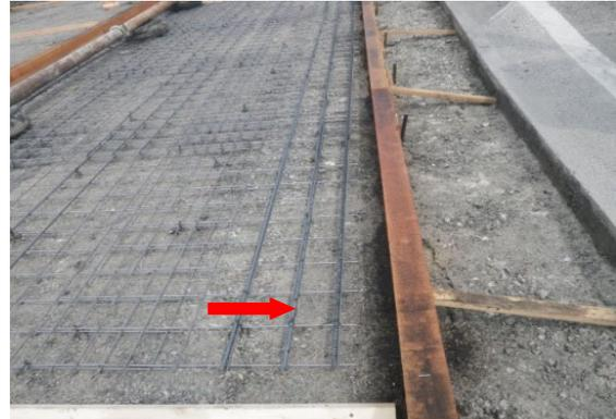
図 4-8-2 縦縁部補強筋（矢印）の設置状況
