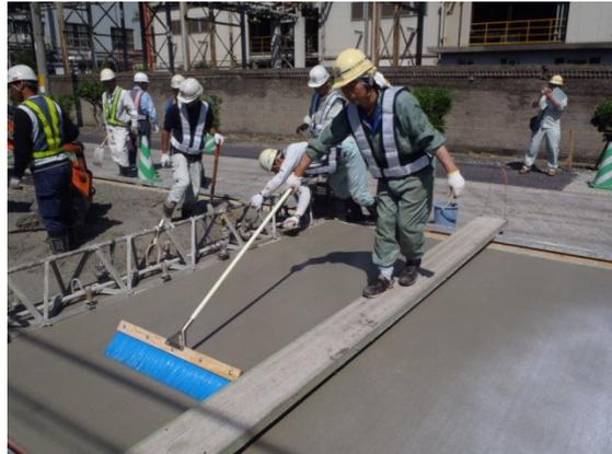
図 4-14-2 ほうきによる粗面仕上げ状況
