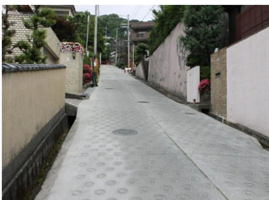
図 4-15-5 リング仕上げ完了
