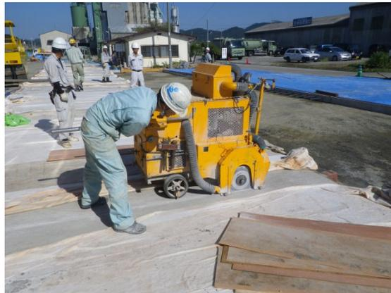
図 4-17-1 カッタ目地工の施工状況
