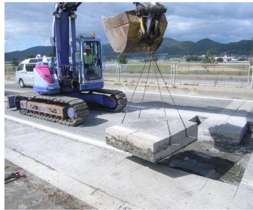
図 4-3-3 吊り上げ撤去
