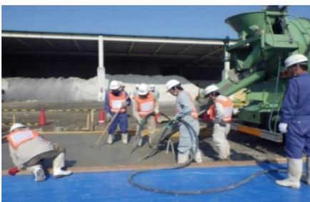
図 4-9-1 トラックアジテータからの直接打込み
