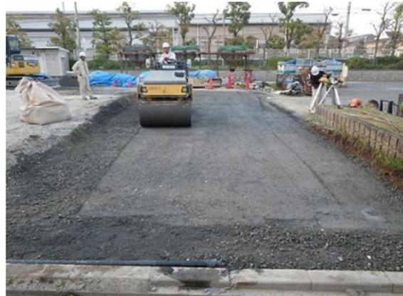
図 4-5-6 ロードローラによる転圧
