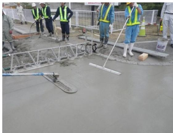
図 4-12-4 フロートによる平たん仕上げ状況
