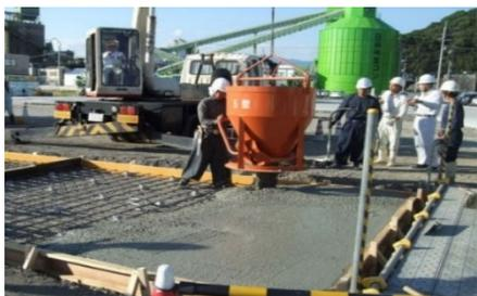
図 4-9-3 ホッパによる打込み
