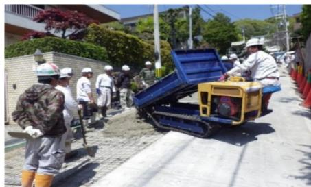
図 4-9-4 小型クローラ運搬車による打込み
