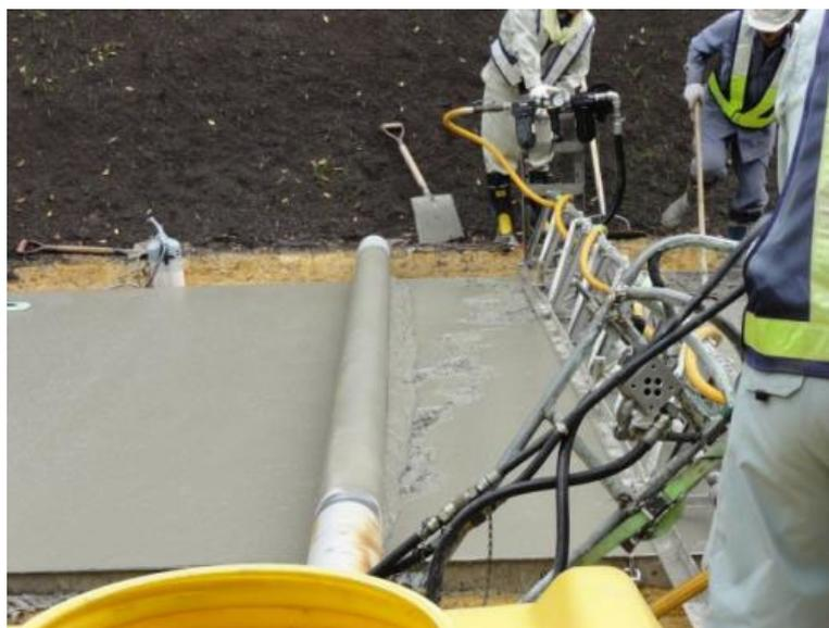
図 6-2-26 ローラーフィニッシャによる仕上げの様子
