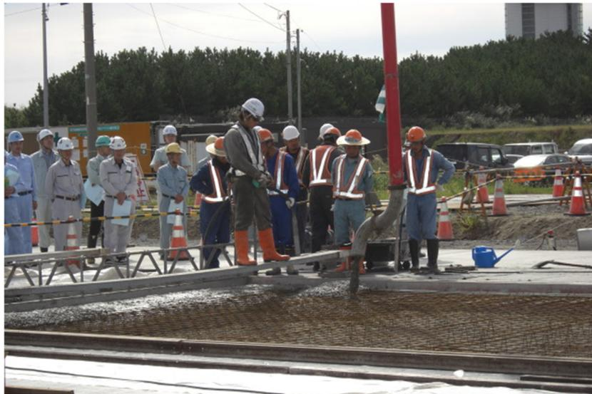
図 6-2-7 締固めおよび仕上げの様子
