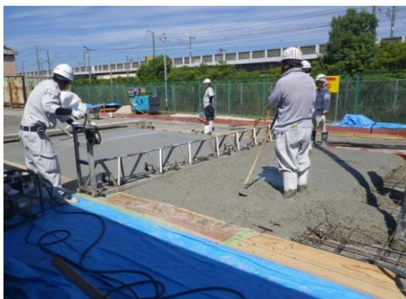
図 4-12-1 トラススクリードによる平たん仕上げ状況
