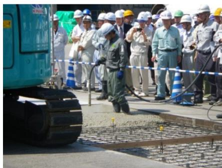
図 4-11-1 高周波バイブレータによる締固め状況
