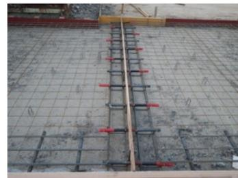
図 2-2-3 横伸縮目地 (膨張目地) の断面図<sup>2-1)</sup> と設置状況
