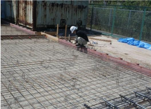
図 4-8-1 鉄網の設置状況
