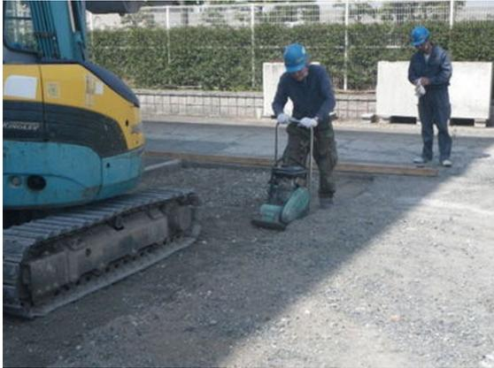
図 4-5-5 振動プレートによる転圧
