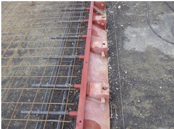
図 4-6-1 舗装用鋼製型枠
