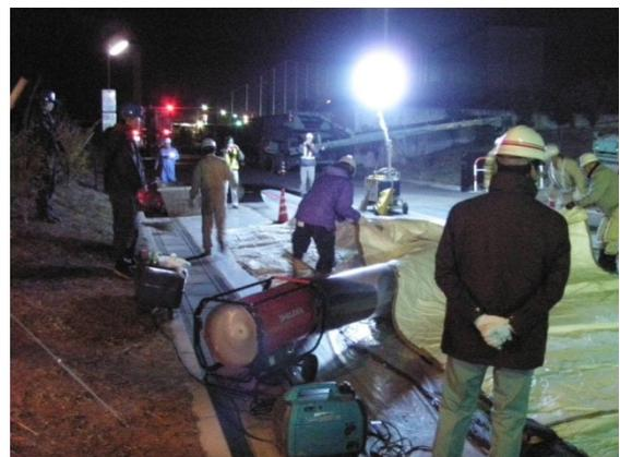
図 4-16-5 ジェットヒーターによる給熱養生
