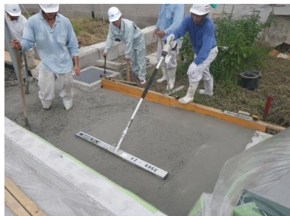
図 4-12-3 振動機付きフロートによる平たん仕上げ状況
