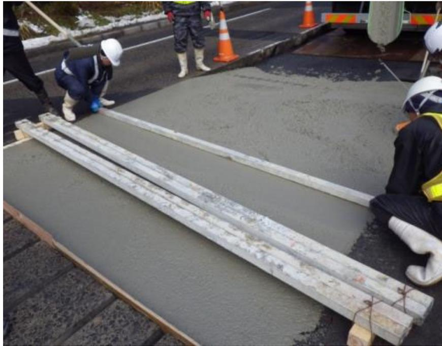
図 6-2-24 打込みおよび平たん仕上げの様子
