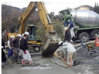
図 4-9-5 油圧ショベルによる打込み
