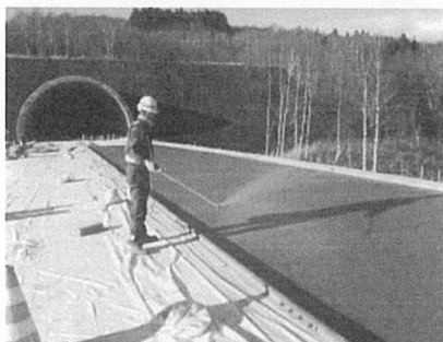
写真20 被膜養生剤散布
