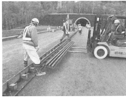
写真5 レールの設置
