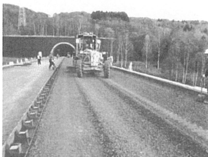
写真1 路盤の整正
