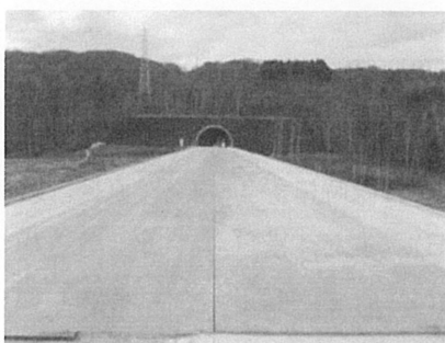
写真23 完了全景(左:起点), (右:終点)
