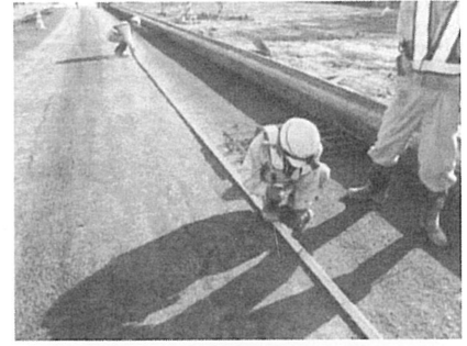
写真6 誘発目地材の設置
