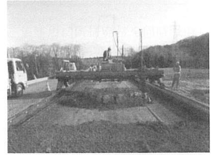
写真9 1層目の敷均し
