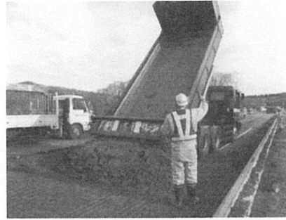
写真8 コンクリートの搬入
