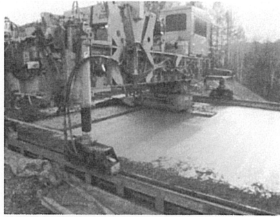
写真14 フィニッシャによる整形仕上げ
