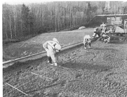
写真10 タイバーの設置
