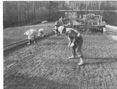
写真11 鉄網、補強鉄筋の設置
