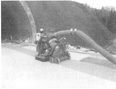
写真24 骨材露出工
