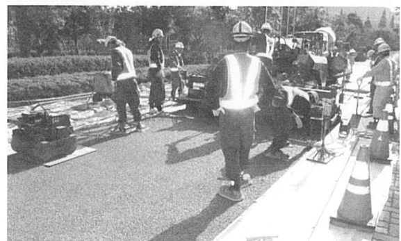
骨材飛散の弱点を克服したきれいな仕上がり
