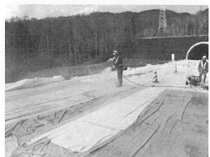
写真21 養生マットで覆い湿潤養生
