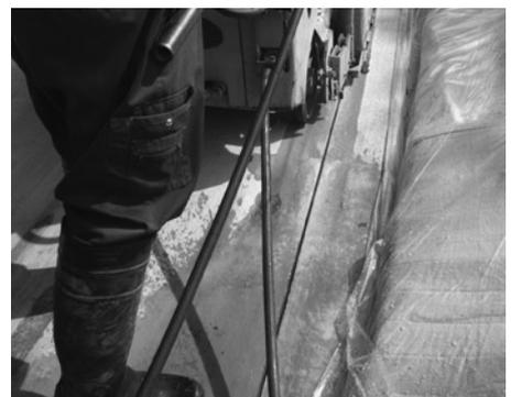
約5mピッチでカッター目地を施工(幅8mm, 深さ70mm)
