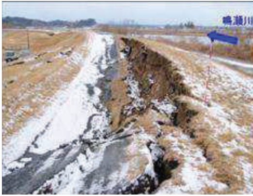
(A) 天端沈下、縦断クラック
