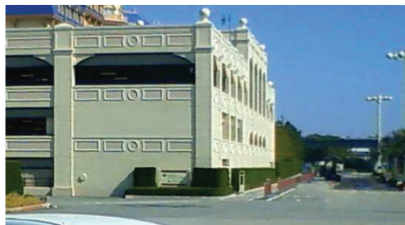
写真 4.4.1 地震後の立体駐車場 (2011.3.13 撮影)
