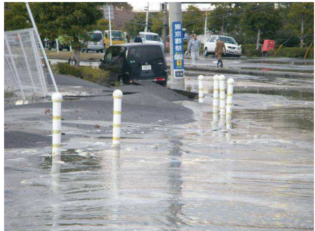
写真 4.5.5 周辺道路の液状化
