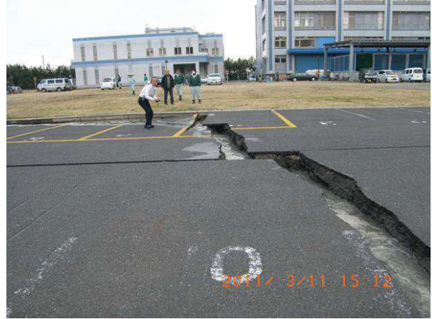
写真 4.5.3 舗装の損傷
