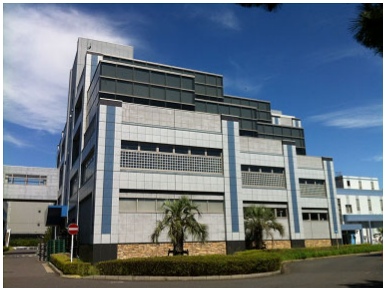
写真 4. 5. 1 浦安市クリーンセンター 再資源化施設 全景
