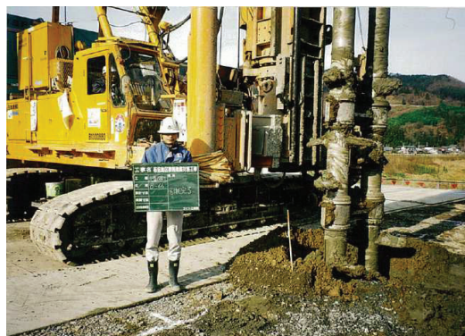
施工状況その2
