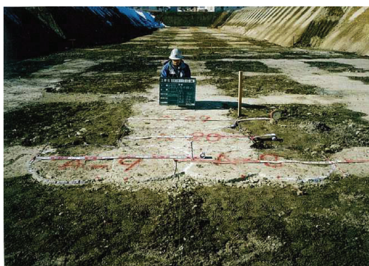
施工完了・掘削状況
