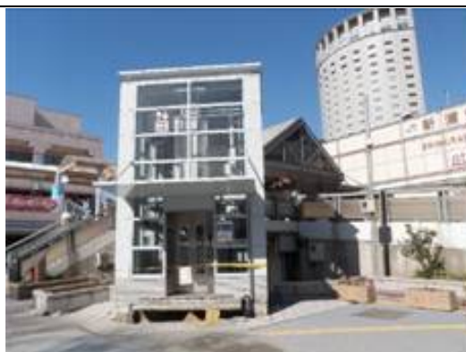
写真① エレベータ本体（被害なし）
