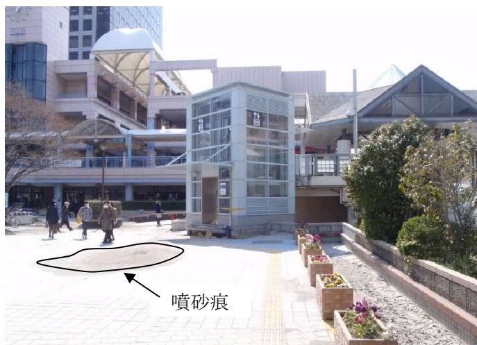
写真③ 周辺地盤（噴砂痕あり）
