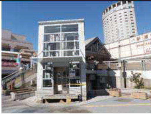
写真① エレベータ本体（被害なし）
