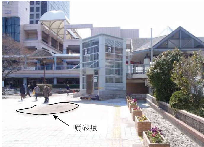
写真③ 周辺地盤（噴砂痕あり）
